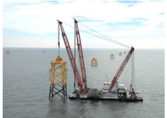
風力機組安裝作業
