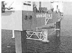
預打基樁作業
