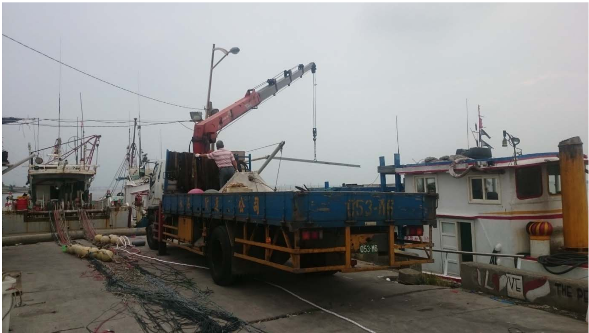
圖B.3 準備吊運相關設備至作業船隻
