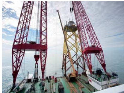
基礎設置安裝作業示意圖
