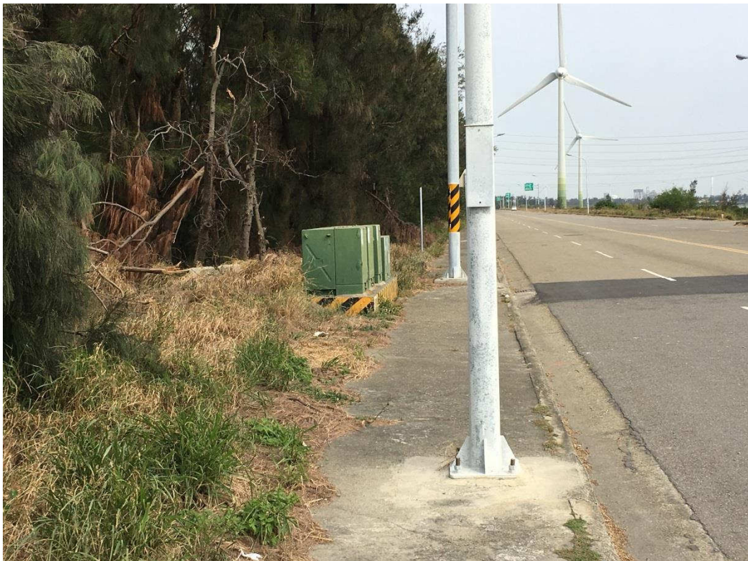
照片二十 T4 量測點附近之路燈與變電箱
