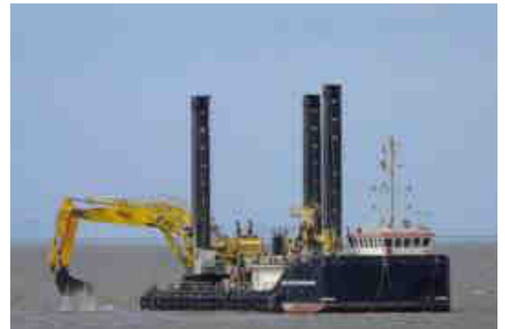
Backhoe Dredger (BHD)
