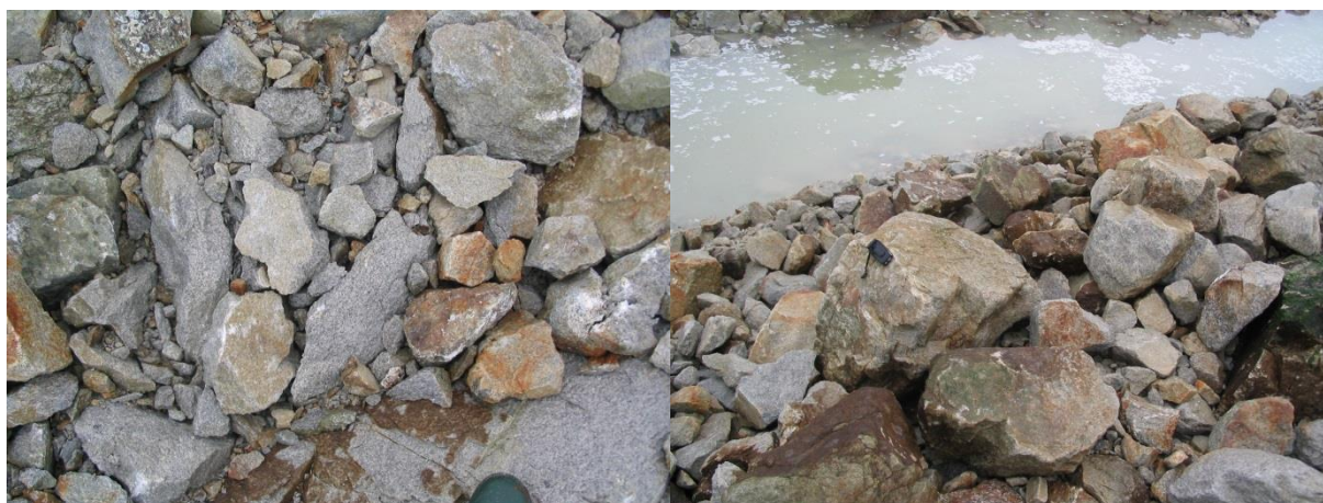
Figure 16 : Matériaux extraits à la pelle après minage (Le Pouliguen)
