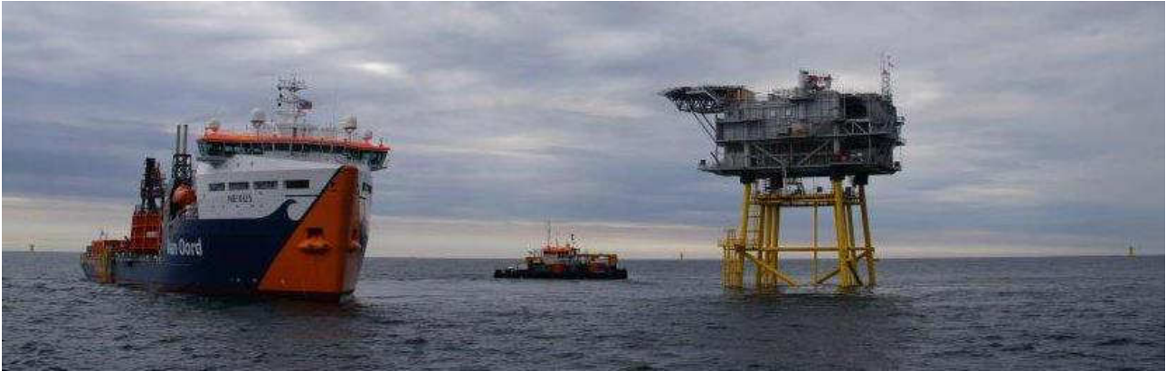
Photographie 14 : Poste électrique en mer
