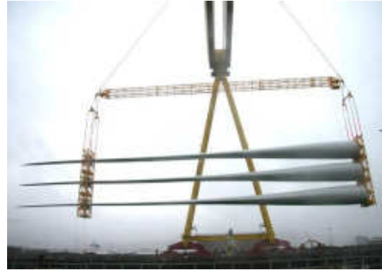
Pales en cours de démontage (www.marinelog.com)
