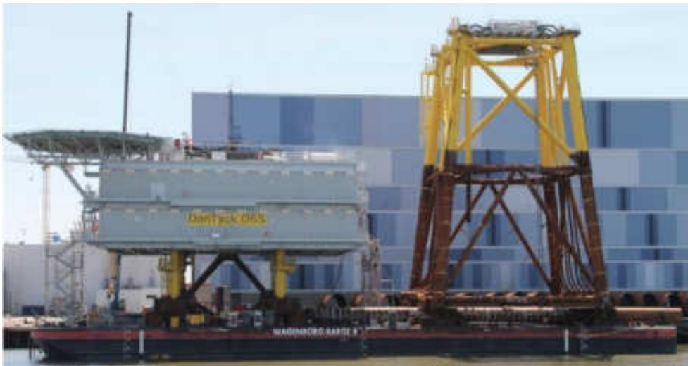
Photographie 13 : Transport de la fondation et de la plateforme du post électrique en mer
