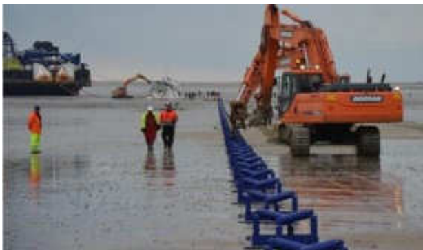
Câble tiré du navire câblé vers la chambre d'atterrage
