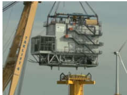
Dépose du poste électrique (Belwind video)
