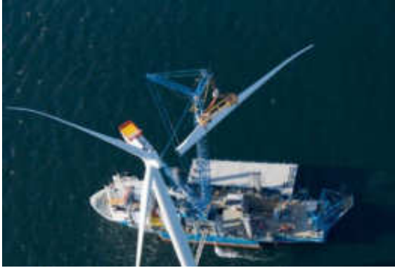
Photographies 20 : Opérations de démantèlement des éoliennes
