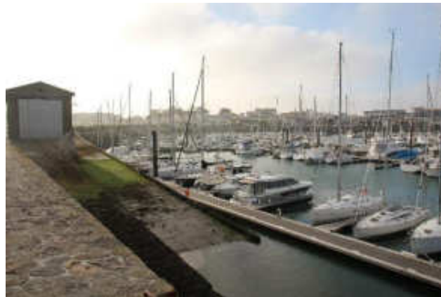
Photographie 88 : Abri canot de sauvetage et cale de mise à l'eau
