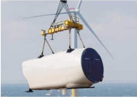
Dépose de la nacelle (www.fk-wind.dk)
