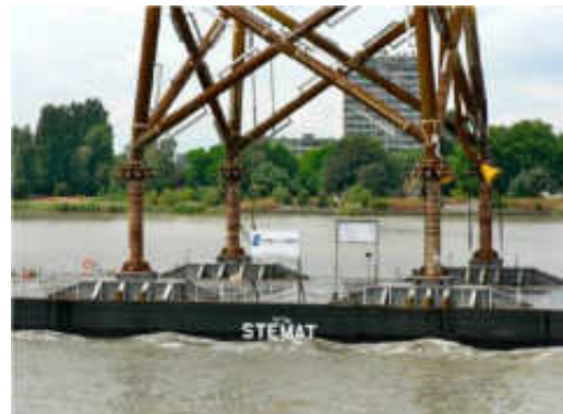
Chargement et mise en sécurité sur la barge (source : www.heavyliftspecialist.com )
