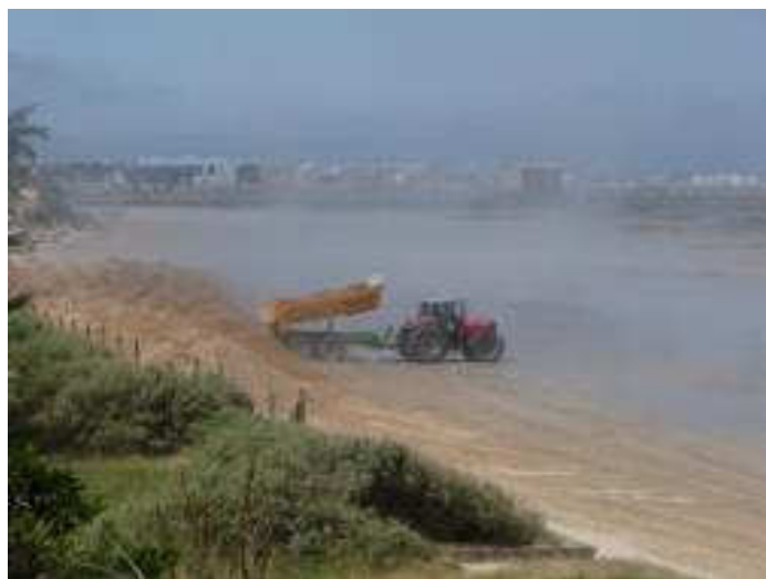
Photographie 46 : Rechargement en sable à la Linière
