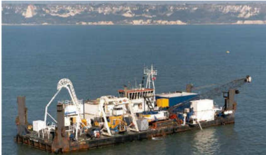
Photographie 31 : Barge aménagée pour l'installation de câble en secteur côtier
