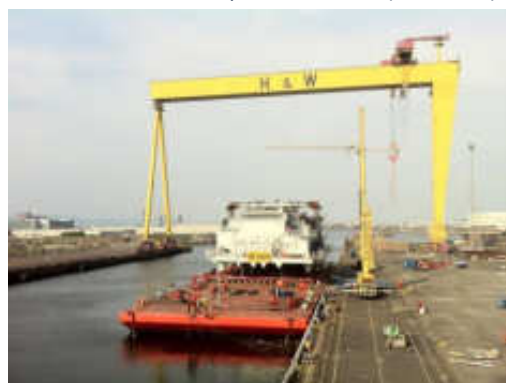
Déchargement du poste électrique en mer (www.siemens.co.uk)
