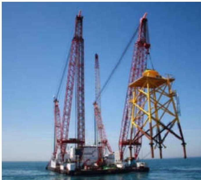
Photographie 9 : Installation d'une fondation jacket
