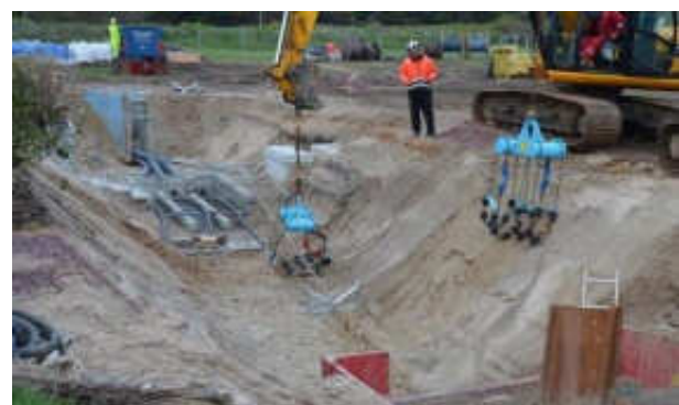
Tirage au niveau de la chambre d'atterrage
