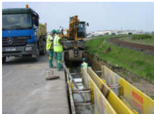
Pose en bord de chaussée
