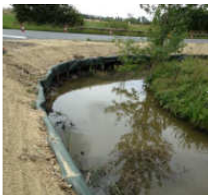
Photographie 44 : Exemple de fascine réalisée sur une route départementale du Marais Breton
