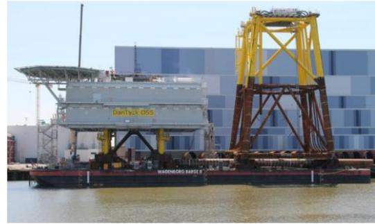
Déchargement avant stockage et désassemblage
