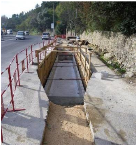
Exemple du génie civil
