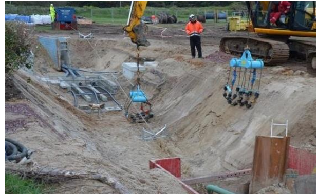
Tirage au niveau de la chambre d'atterrage
