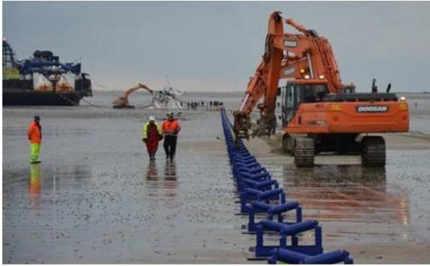
Câble tiré du navire câblé vers la chambre d'atterrage
