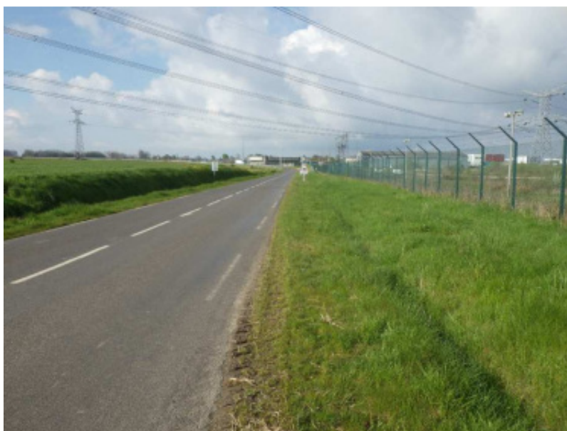
Figure 175 : La D313 au droit du futur poste électrique
