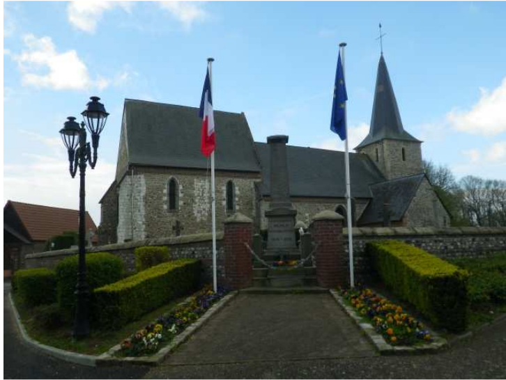
Figure 174 : Eglise de Penly
