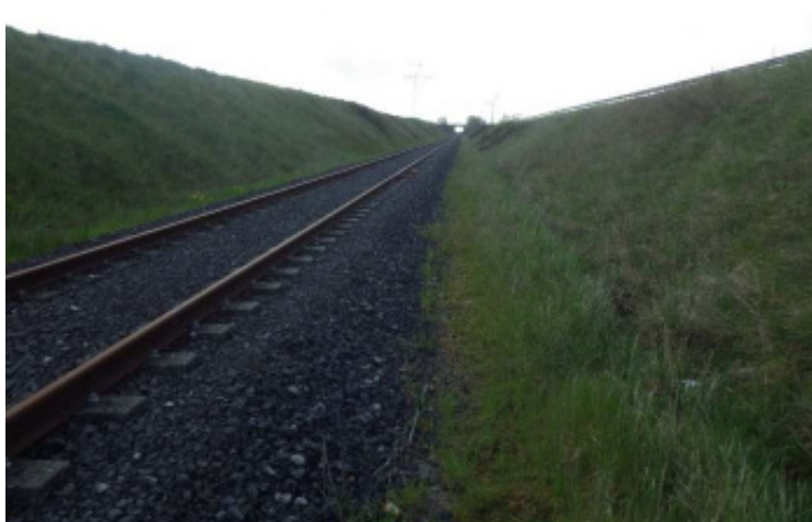
Figure 179 : Voie ferrée au droit du futur poste électrique
