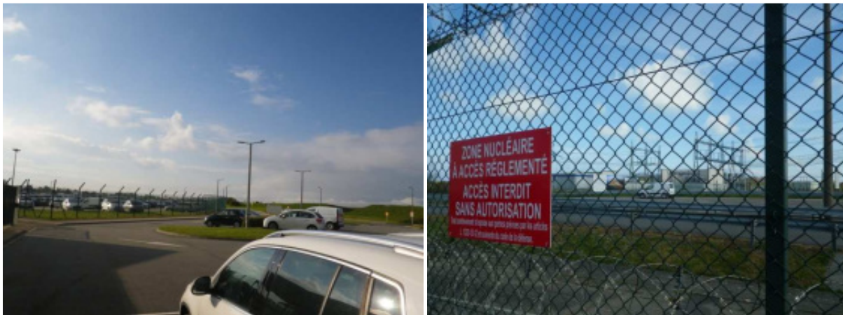
Figure 172 : Accès, stationnements et protections importantes de l'emprise de la centrale nucléaire de Penly
