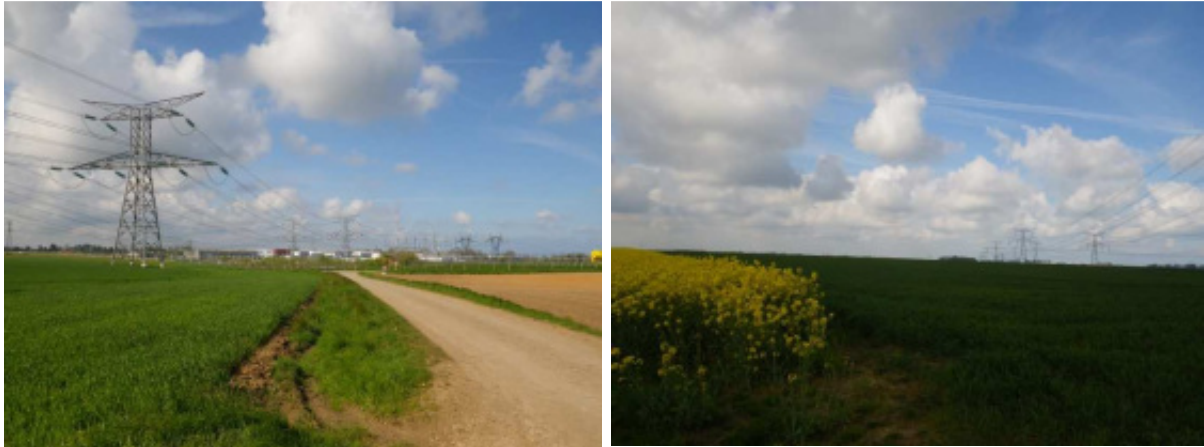
Figure 171 : Lignes à haute tension au niveau du poste de Penly et sur Brunville
