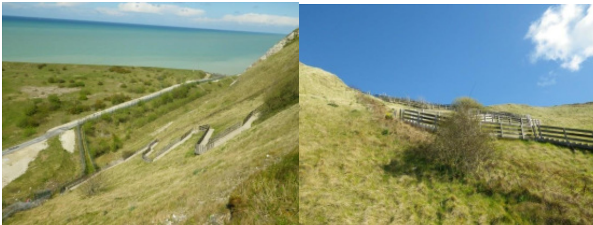
Figure 11 : Pose et protection de la liaison souterraine
