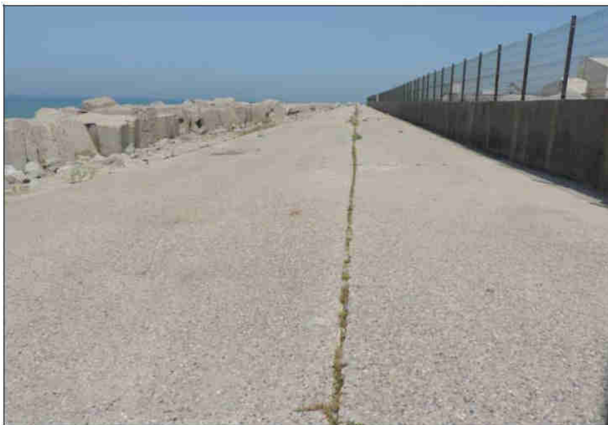
Figure 44 : Prise de vue de la digue lors de l'inventaire
