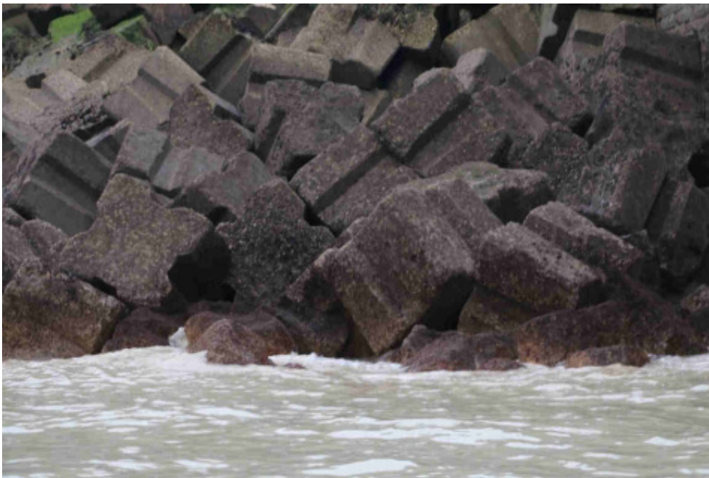
Figure 54 : Photographie des enrochements du quai Gaston Lalitte
