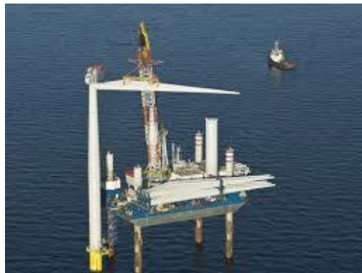
Pales en cours de démontage ( www.marinelog.com )
