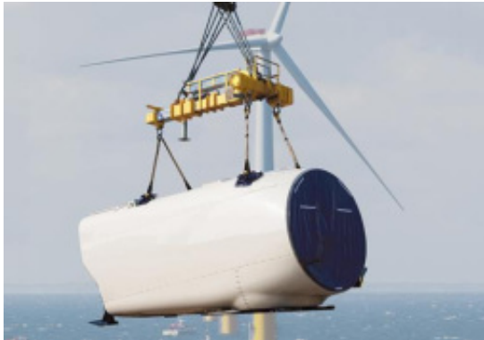
Dépose de la nacelle (www.fk-wind.dk)
