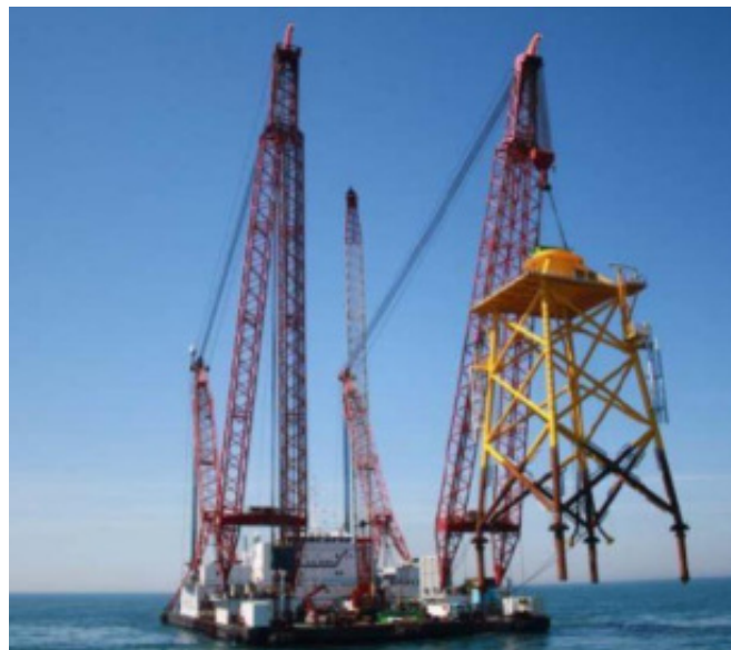
Figure 35 : Installation d'une fondation jacket
