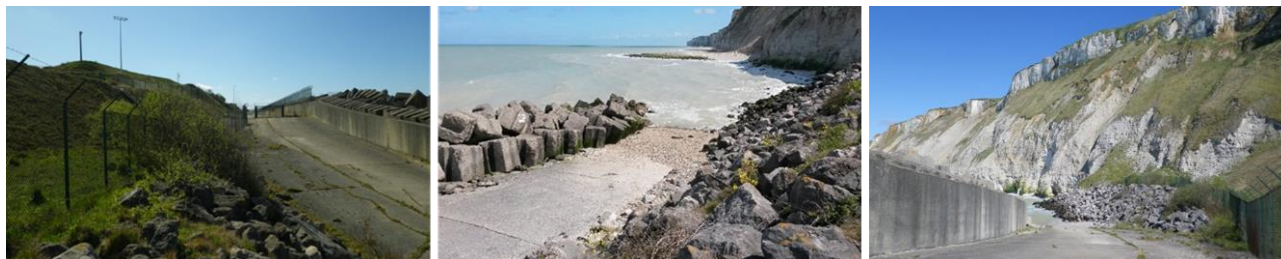
Figure 115 : La cale à bateau de la zone d'atterrage
