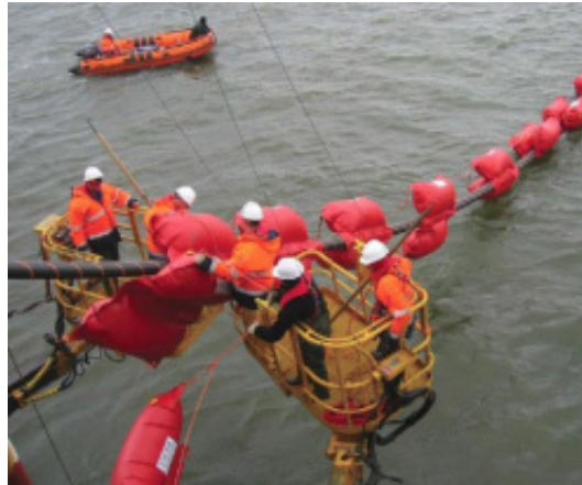
Figure 109 : Mise en place de flotteurs autour du câble durant la phase de tirage vers la cote
