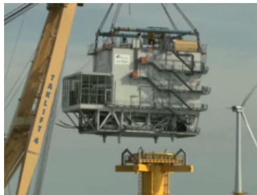
Dépose de la plateforme (Belwind video)
