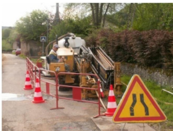
Figure 125 : Atelier de forage
