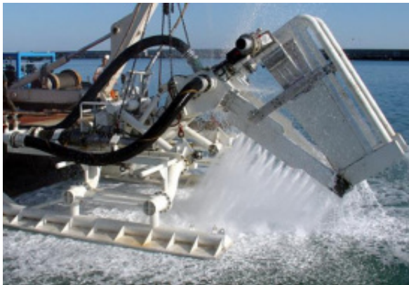
Exemple de jetting
