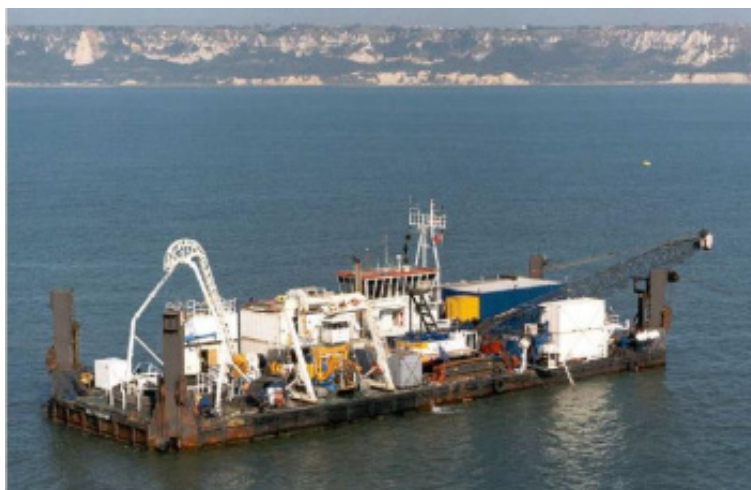
Figure 97 : Barge aménagée pour l'installation de câble en secteur côtier
