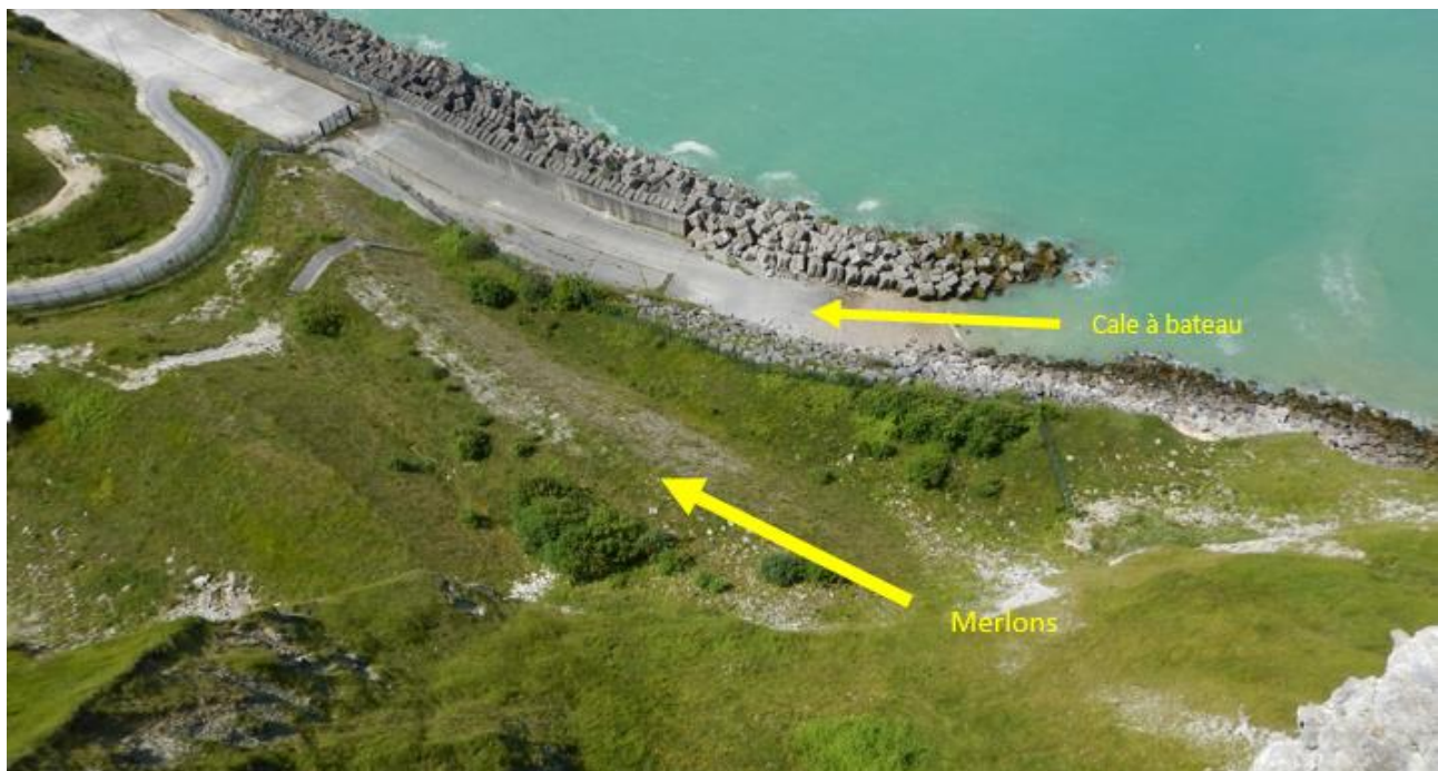
Figure 113 : Vues sur la cale à bateau et le merlon
