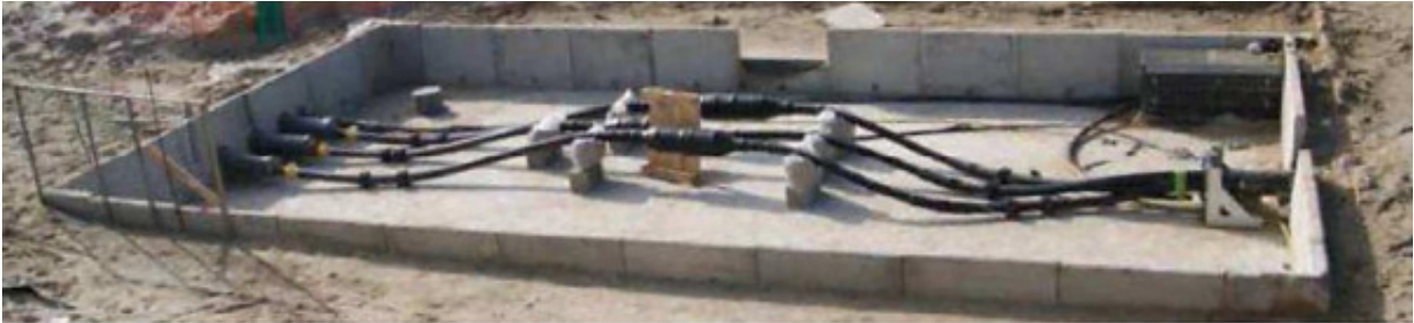
Figure 116 : Chambre de jonction d'atterrage
