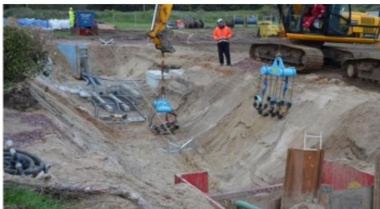
Figure 111 : Tirage au niveau de la chambre d'atterrage
