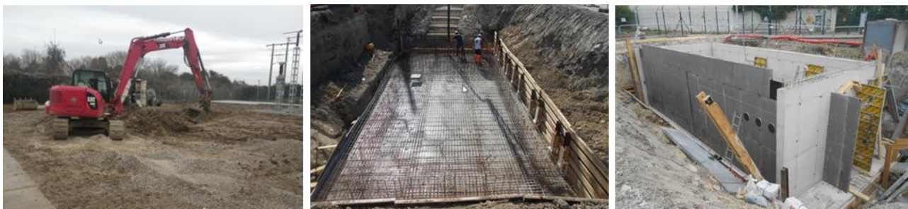
Figure 138 :Travaux de génie civil
