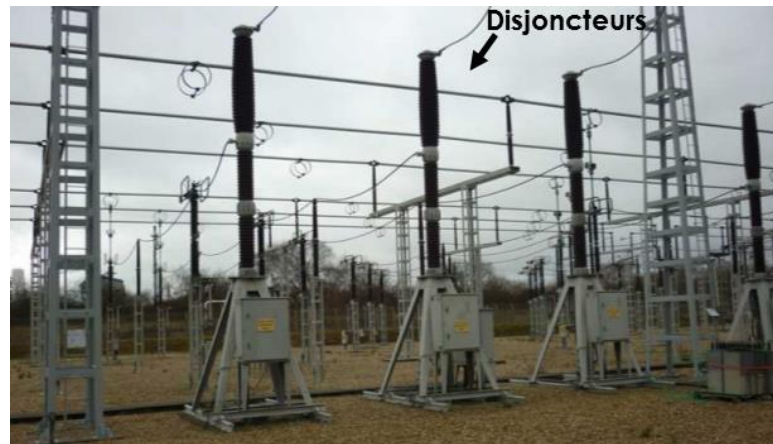
Figure 134: Disjoncteurs
