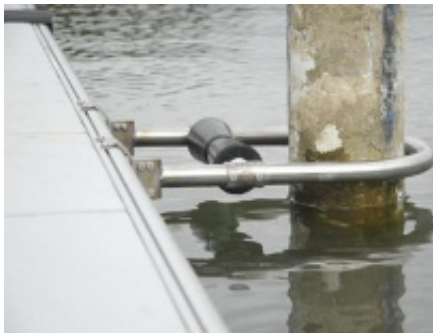
Figure 77 : Etriers sur pieux battus
