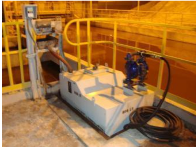
Figura 1-57: Equipo “Skimmer” para recuperar mezclas oleosas del agua
