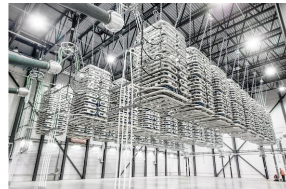
自励式高圧直流送電のバルブホール（変換施設） （出所：日立）
