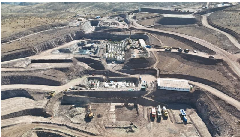
選鉱プラント(建設中)(提供:日鉄鉱業株式会社)
