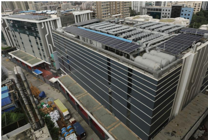
データセンターのイメージ(提供:NTT Global Data Centers & Cloud Infrastructure India Private Limited)
