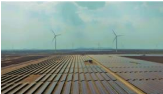
Clean Maxが運営中の再エネアセット (出所:大阪ガスHP)
