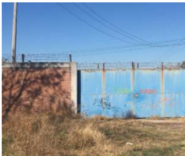
Imagen 22. Instalación donde se ubica uno de los pozos que suministran agua a la CT Salamanca (al este del predio de la CT)
