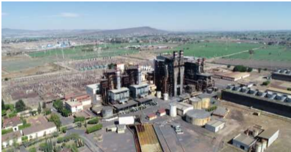
Imagen 3. Central termoeléctrica, subestación asociada y campos de cultivo al norte y este del predio (imagen tomada con Dron)
