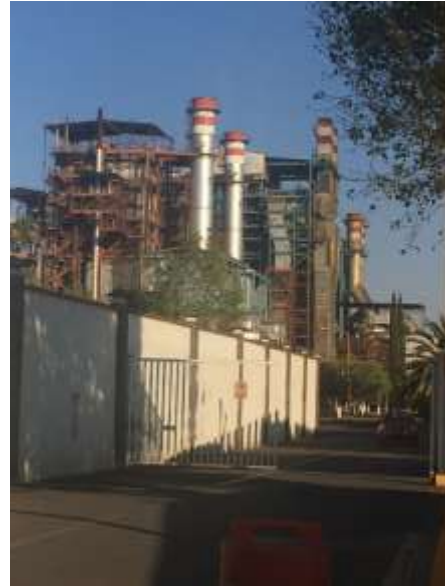
Imagen 6. Acceso principal a la Central Termoeléctrica Salamanca
