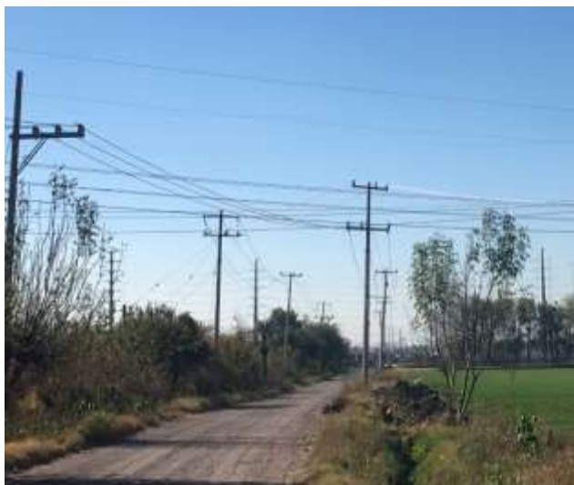
Imagen 1. Vialidad propuesta para acceder al ala este del predio de la CT Salamanca durante la construcción de 347 CC Salamanca
