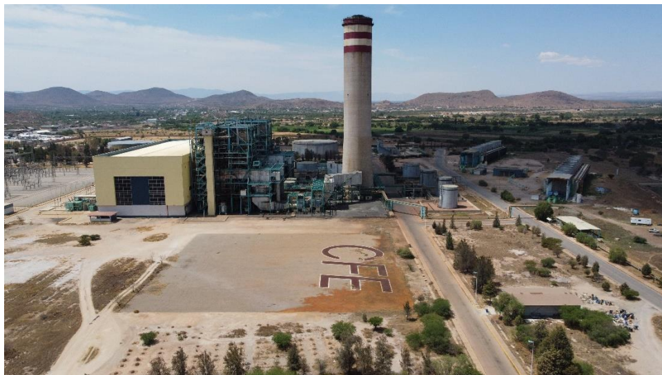
Figura 9. Sitio para la instalación de las unidades
