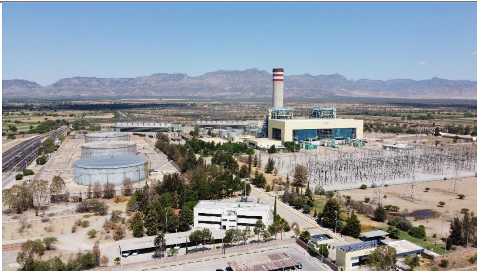
Figura 7. Vista parcial de la CT Villa de Reyes.
