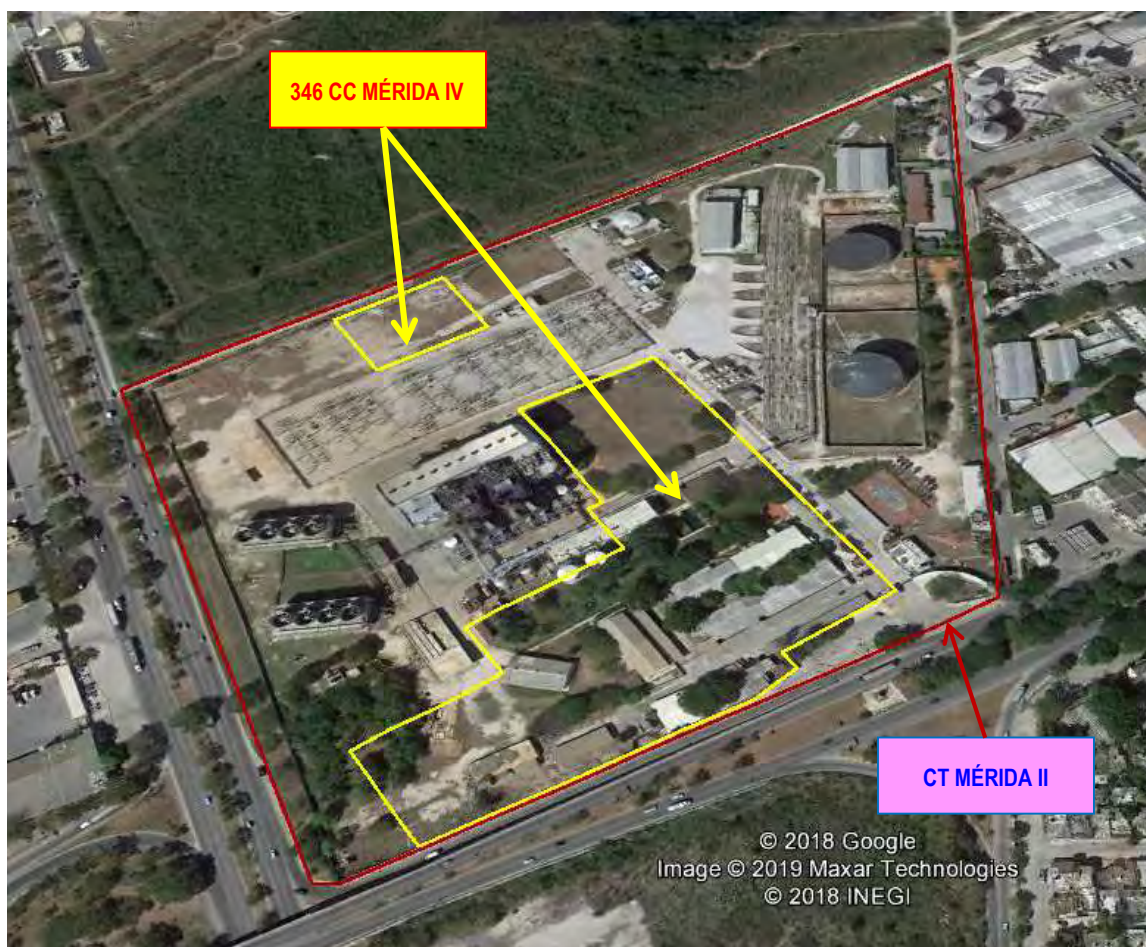
Figura II.1.2-2. Superficie destinada al Proyecto dentro de la CT Mérida II
