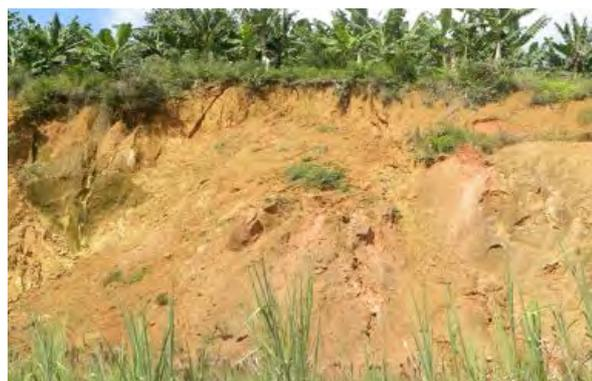
Foto 10.1-30: Exposição de argissolo vermelho-amarelo em talude de corte. Tipo pedológico que em situações mais críticas está sujeito a instabilização, conforme observado no talude, presente nas margens da SC 415, na região de Massaranduba de Baixo, Massaranduba/SC. Coord.: 22 J 706475 m E 7059175 m S.
