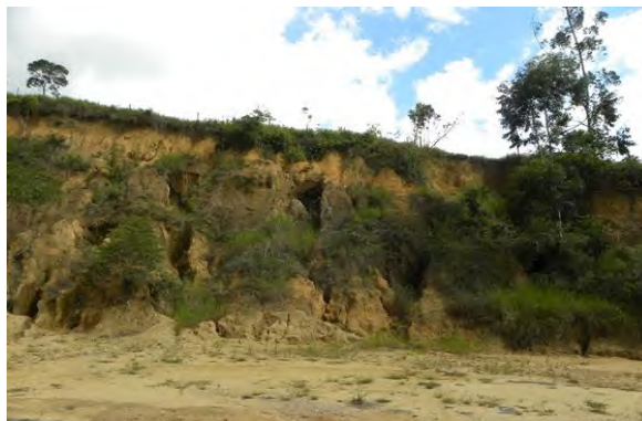
Foto 10.1-90: Erosão linear profunda (ravinamento) sobre talude de corte, envolvendo argissolo e rocha saprolítica, expostos na região de Azambuja, município de Brusque/SC. Coord.: 22 J 714421 m E 7000765 m S.
