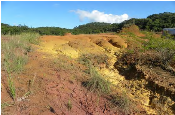
Foto 10.1-82: Evidência de erosão rasa passando a profunda em terreno de baixa declividade natural, condição favorecida pela remoção da capa de solo superficial (ação antrópica), exposição da rocha saprolítica frágil e concentração de águas pluviais sobre o terreno. Registro realizado na região de Corticeira, município de Guaramirim/SC.22 J 704895 m E 7073868 m S.
