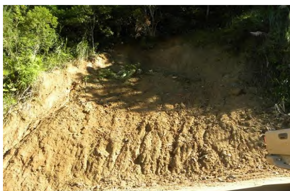
Foto 10.1-92: Detalhe de escorregamento circular envolvendo massa saprolitizada e cambissolo, condicionada pela exposição do material sobre um talude de inclinação acentuada, onde o material superficial comprometido pelo acúmulo de água pluvial veio a instabilizar. Situação presente na região da Vila Dose de Outubro, município de Antônio Carlos/SC. Coord.: 22 J 715199 m E 6967724 m S.
