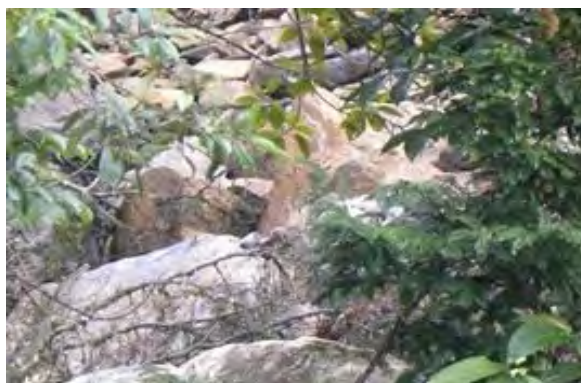
Foto 10.1-88: Detalhe de movimento de massa associado a queda de blocos (incorporando neossolo litólico), derivado de movimentação de parte do maciço rochoso, exposto em encosta com declividade da ordem de 60%, presente na região de Grota Funda, município de Schroeder/SC, no entorno do rio Itapocuzinho. Coord.: 22 J 686404 m E 7084957 m S.
