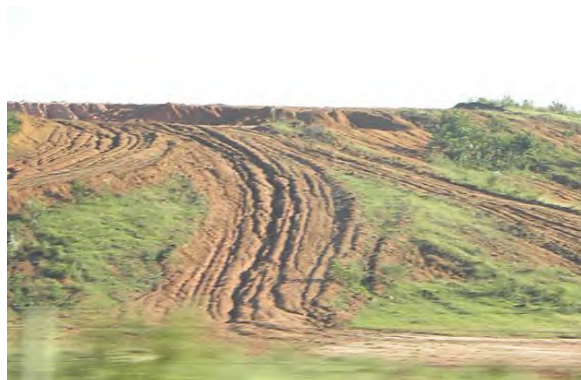
Foto 10.1-85: Caracterização de erosão linear rasa, associada a um terreno exposto por decapeamento superficial do solo, comprometido pela declividade e fragilidade do material exposto. Caracteriza uma condição de risco geotécnico baixo, agravada pela ação antrópica, na região do Ribeirão dos Canelas, município de Jaraguá do Sul/SC. Coord.: 22 J 681080 m E 7070615 m S.
