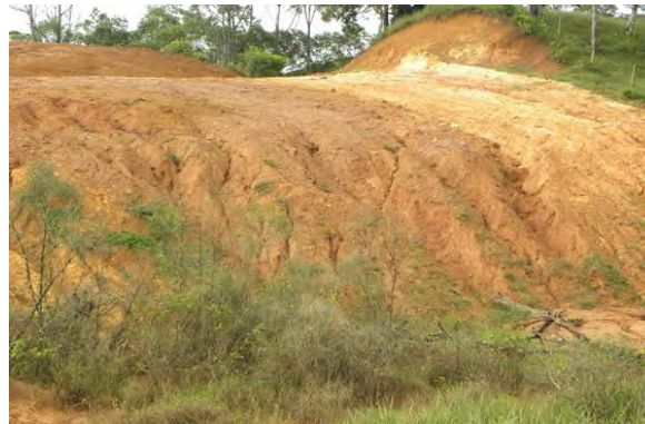
Foto 10.1-81: Detalhe de processo erosivo linear raso, agindo sobre rocha saprolítica em colina suave, condição decorrente da ação de água pluvial concentrada em terreno decapeado. Risco local à erosão baixo, mas comprometido pela ação antrópica. Situação observada na região de Dedo Grosso, município de Joinville/SC. Coord.: 22 J 707661 m E 7080451 m S.
