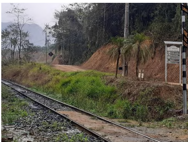
Foto 5.5.4-14: Vista da Localidade Bomplandt.
