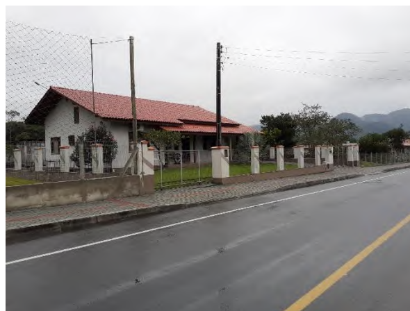
Foto 5.5.4-89: Padrão construtivo em Schroeder III.
