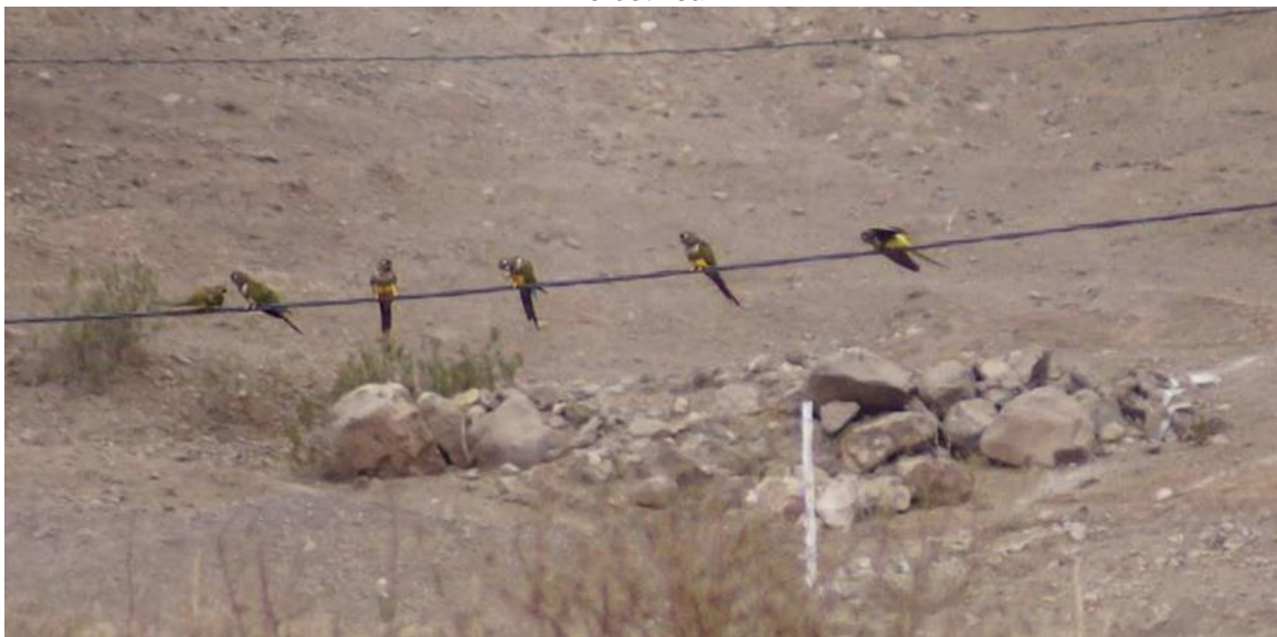
Figura N°303.1. Ejemplares de Cyanoliseus patagonus (loro tricahue) en infraestructura eléctrica
