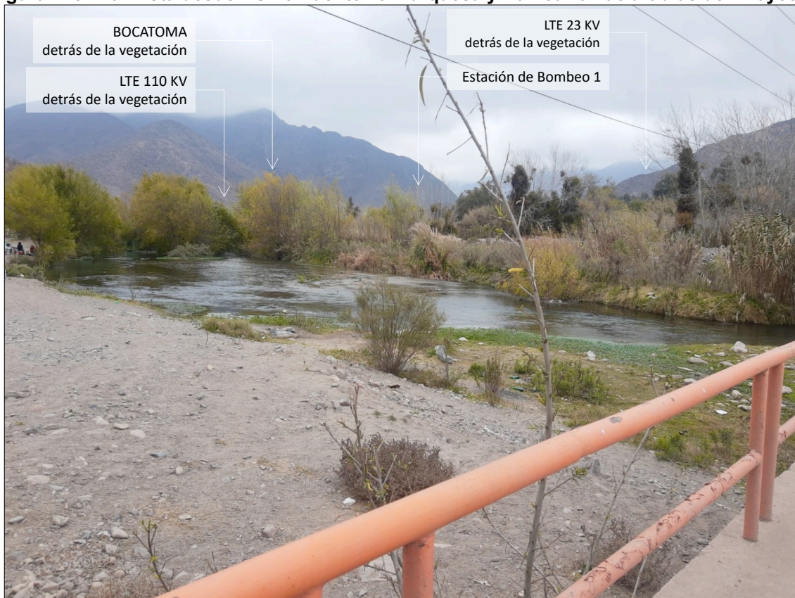
Figura N°54.10: Vista desde PO 43 Puente La Marquesa y Balneario hacia obras del Proyecto
