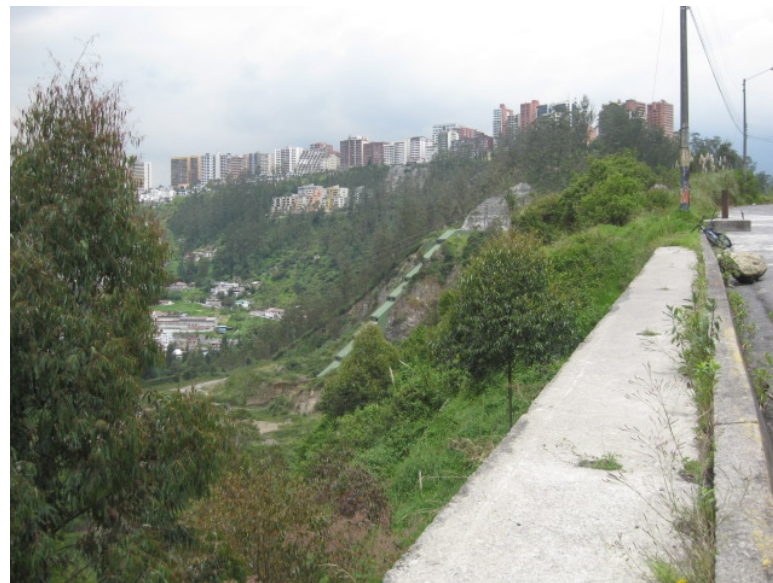
Colectores de agua
