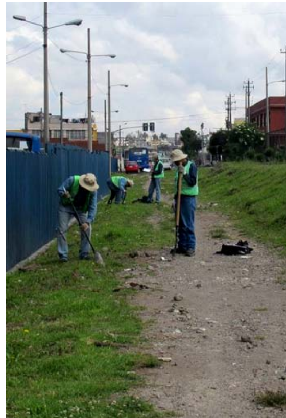
Excavación de PL en el Transecto 2. estación El Recreo
