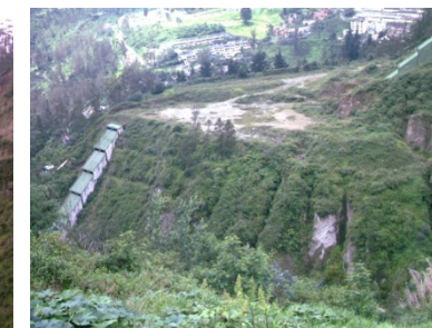
Detalle áreas planas y pendientes de sitio. Existe una central de generación eléctrica aguas abajo
