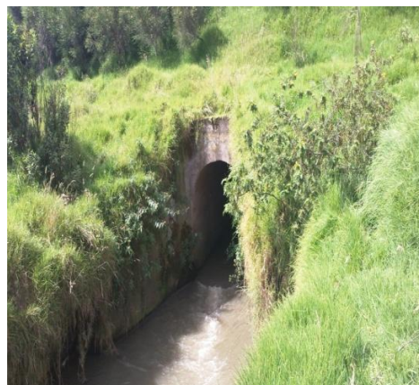
Figura 9 Obra de fábrica bajo la Avenida Huayanay Ñan (OF1)
