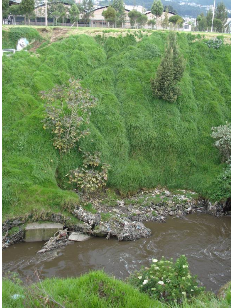
Fotografía 7. Materiales de la ladera oeste de la quebrada
