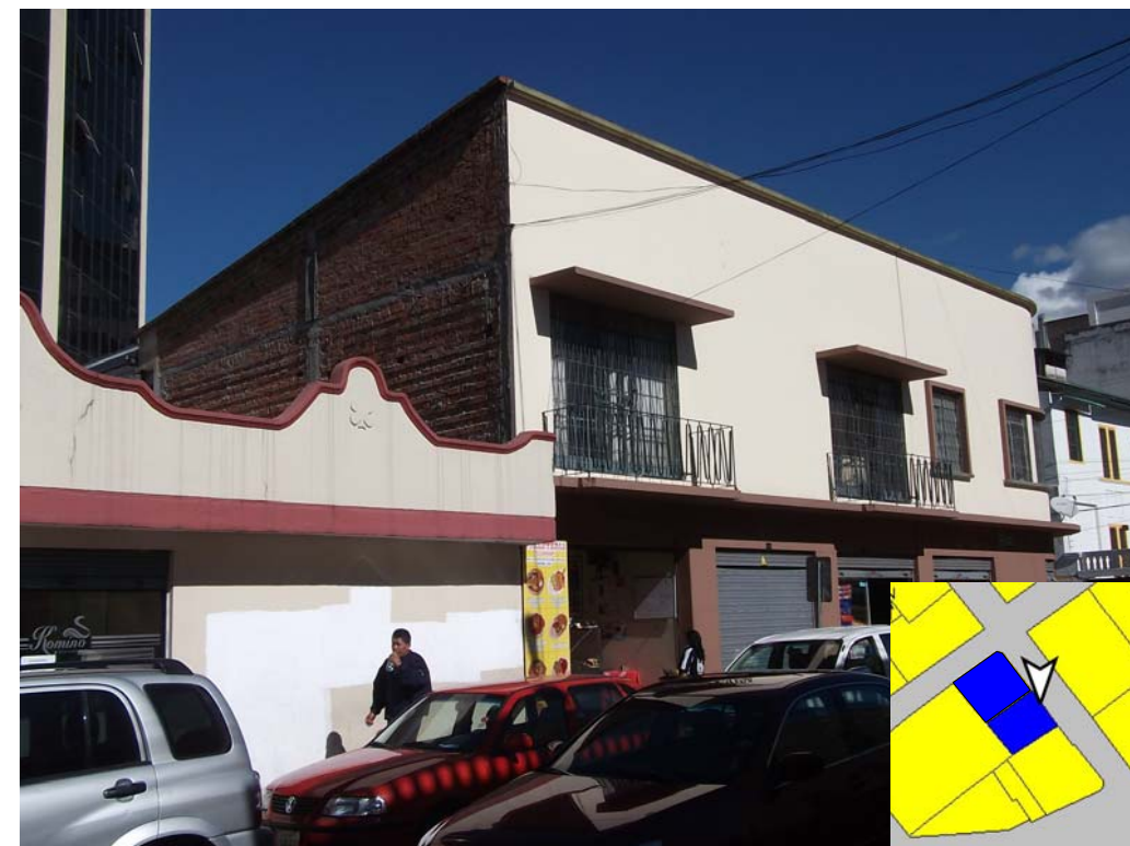
Edificios de 1 y 2 Plantas y 0 Sótanos
