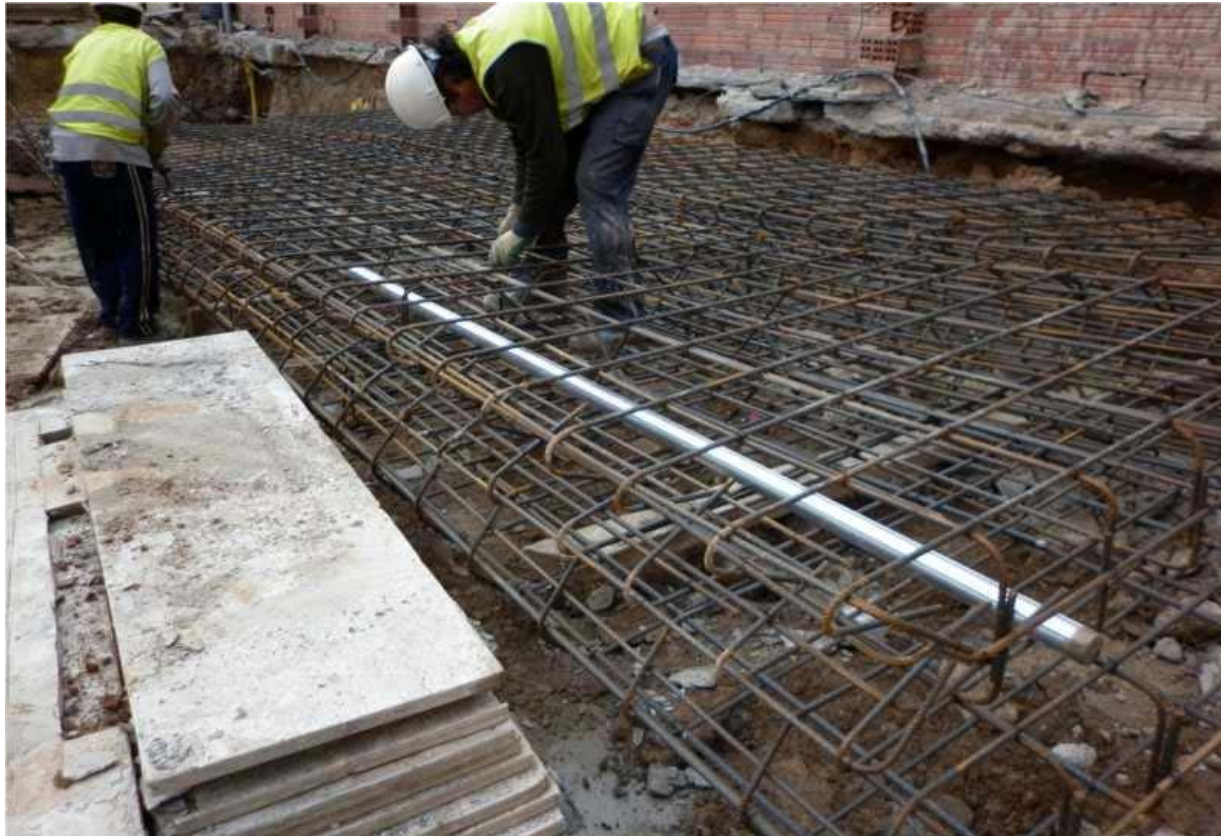
Foto instalación de inlinómetro
