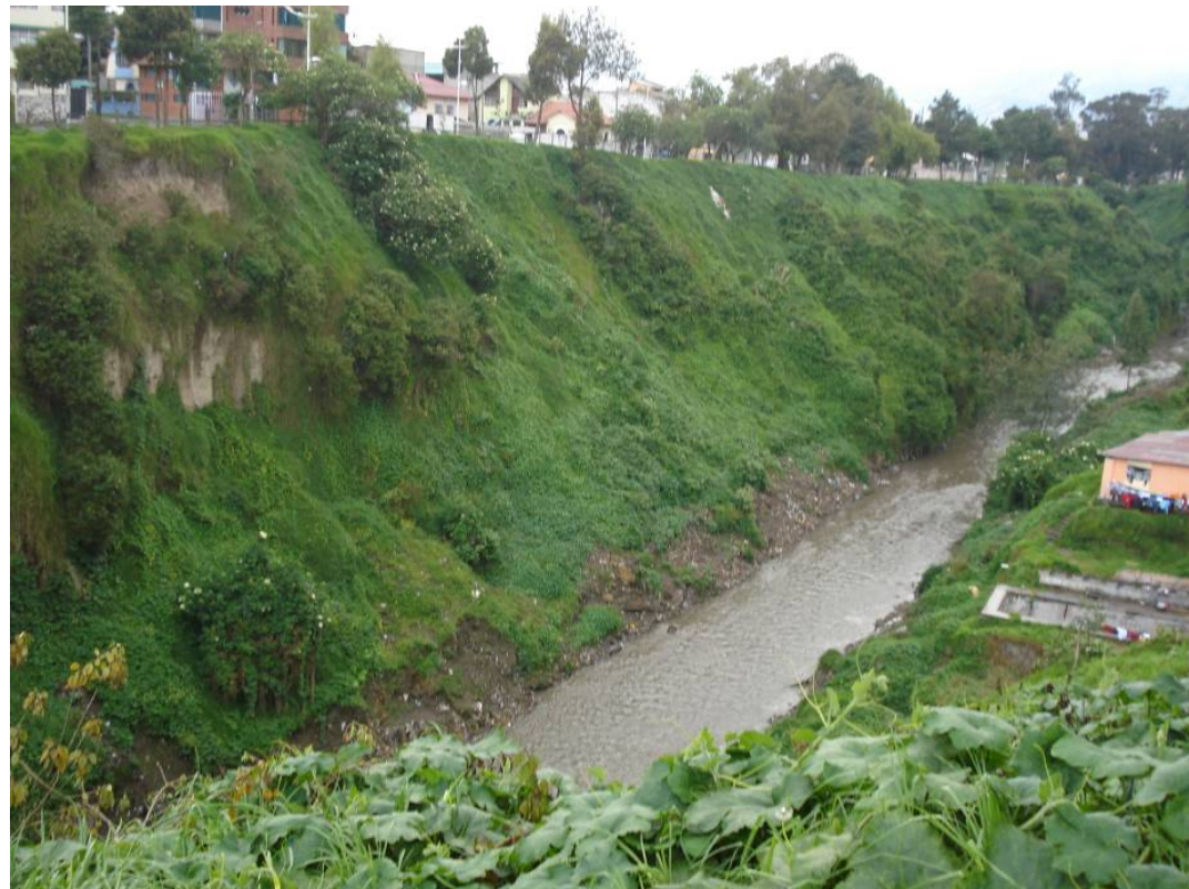
Fotografía 9. Cauce de la quebrada del Machángara en la zona de cruce con la Avda. Rodrigo de Chávez (PK 18+460)
