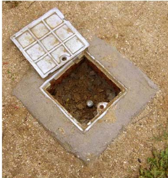
Extensómetro de varilla
