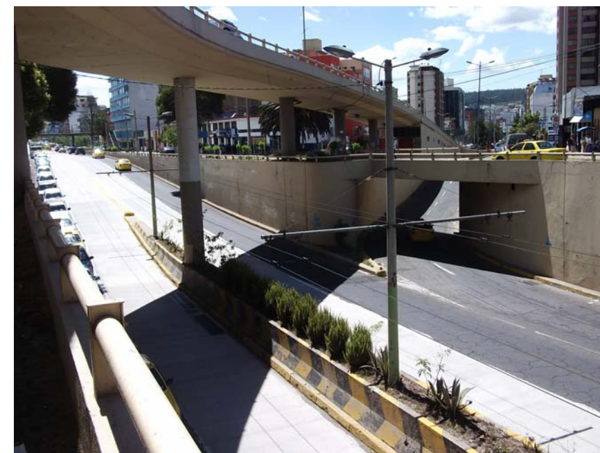
Paso inferior y superior en torno al PK 26+460
