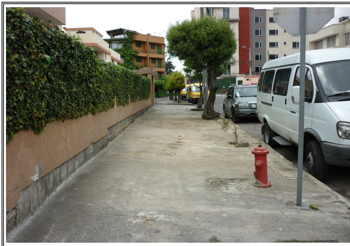
Foto N° 2: Sondeo SMQ - 47 - Fin de sondeo
