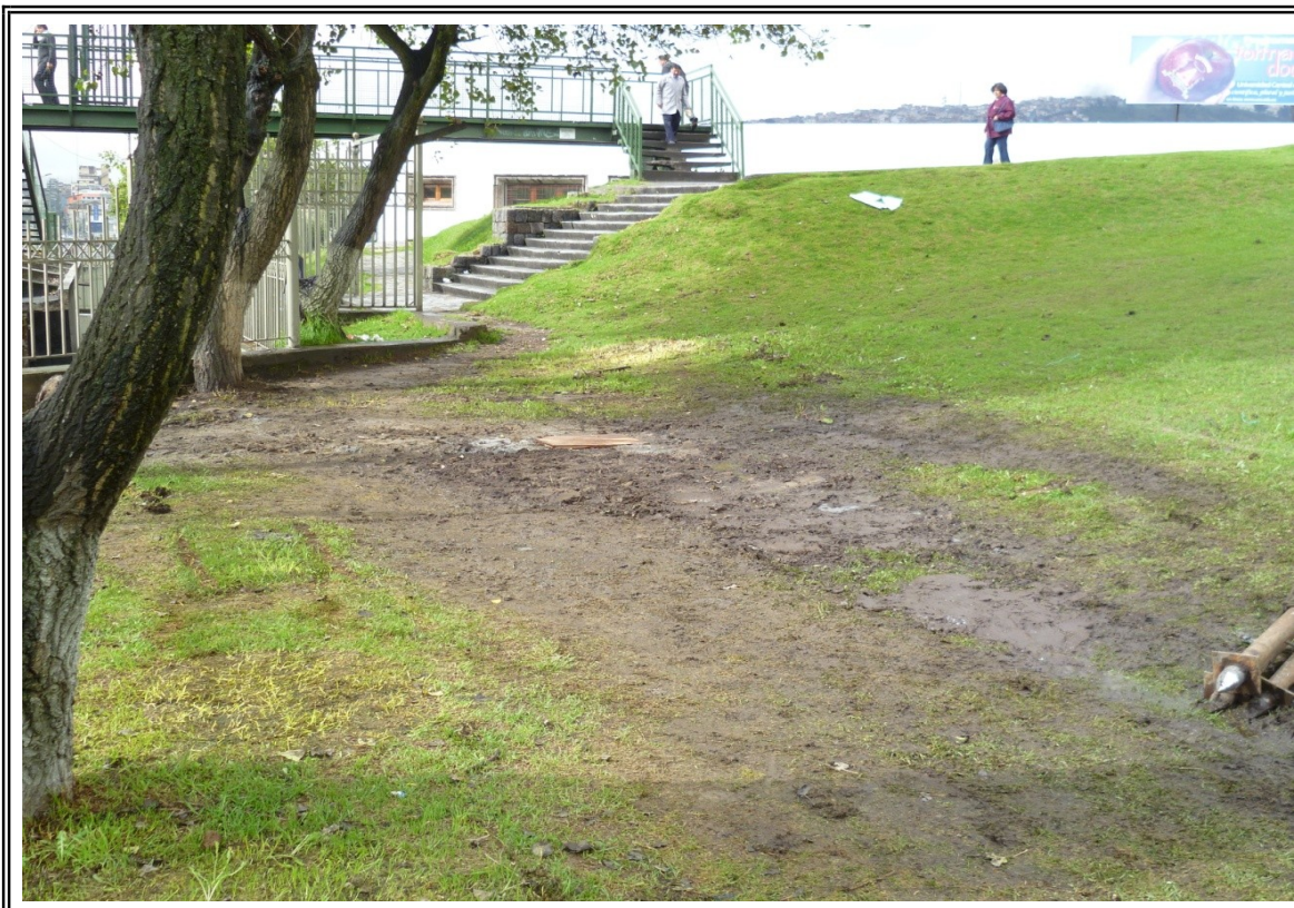
Foto N° 2: Sondeo SMQ -44 - Fin de sondeo
