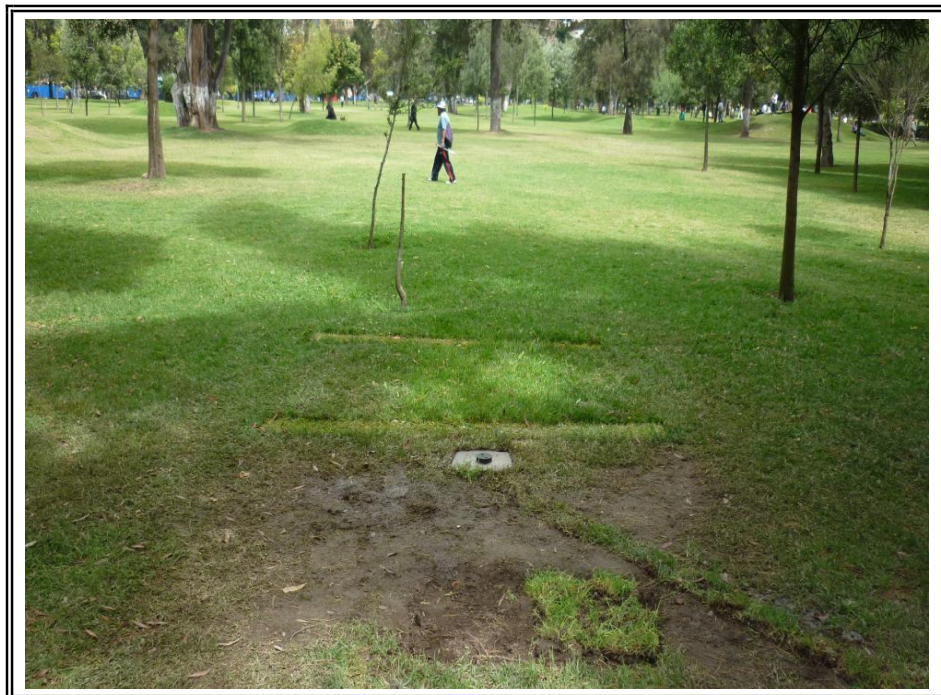
FINALIZACIÓN DEL SONDEO SMQ-41
