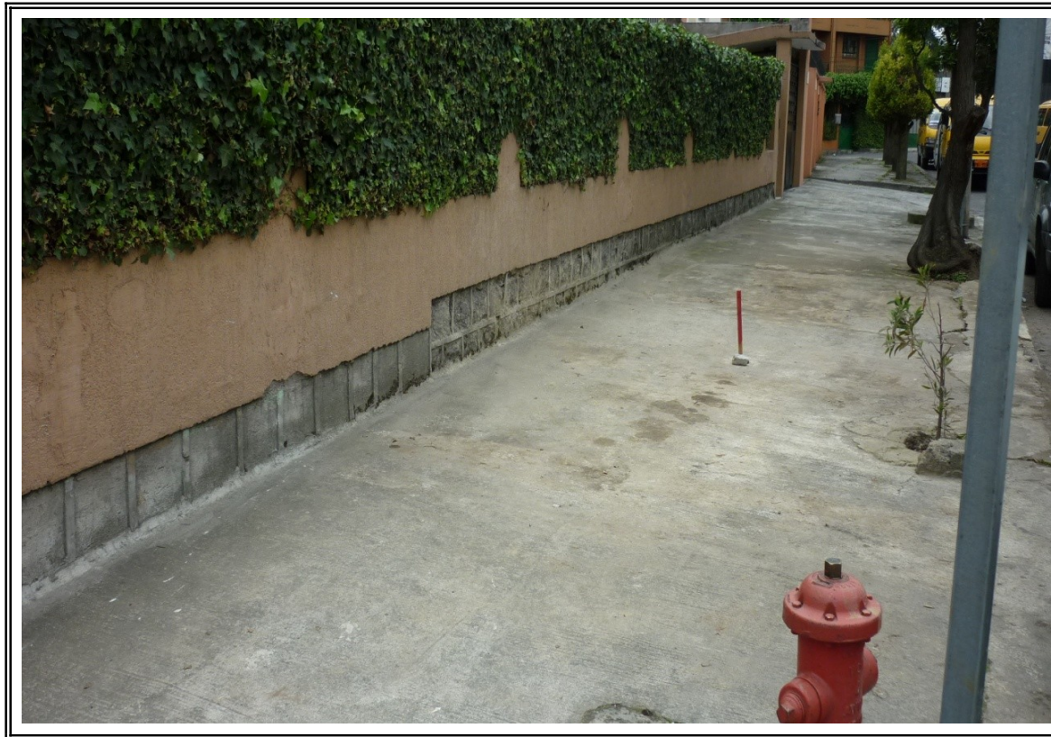
Foto N° 1: Sondeo SMQ - 47 - Inicio de Sondeo
