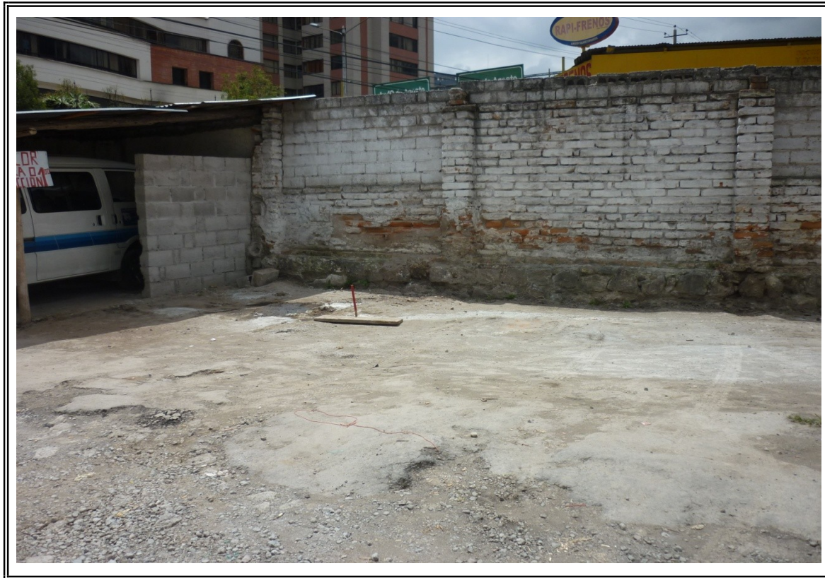
Foto N° 1: Sondeo SMQ -48- Inicio de Sondeo
