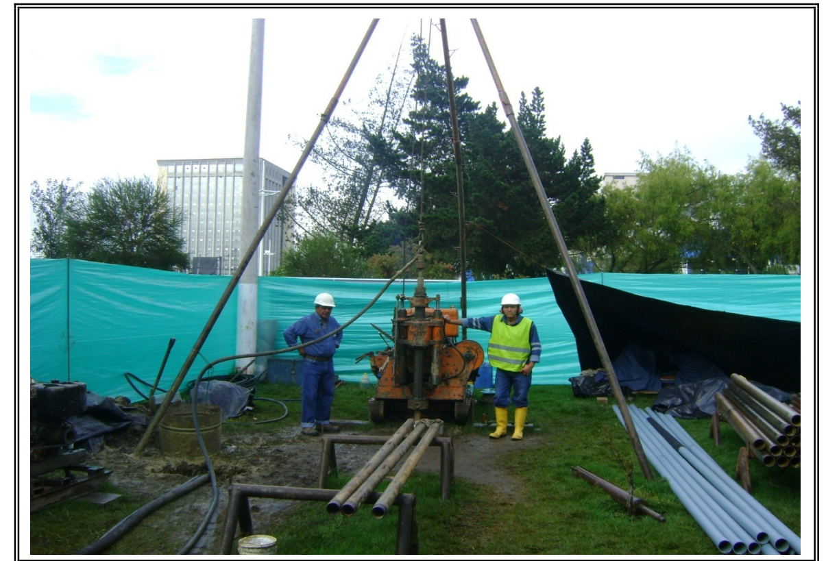
Foto N° 2: Sondeo SMQ - 51 -Registro Eléctrico
