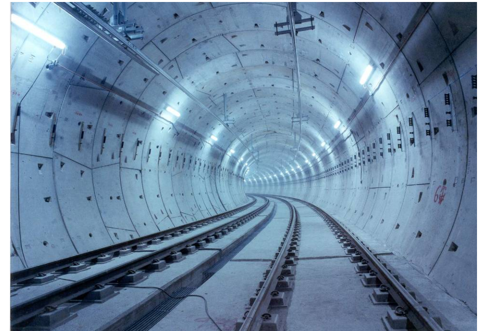
Túnel construido con TBM E.P.B..
