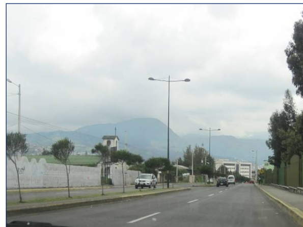
Túnel de línea Quitumbe- Morán Valverde Procedimiento constructivo: entre pantallas
