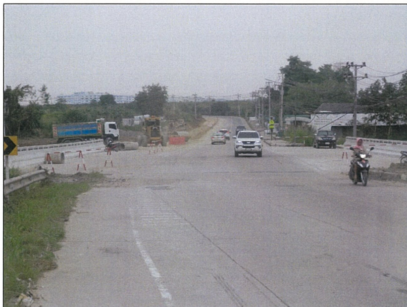
ภาพที่ 5.1.5-1 : กิจกรรมการก่อสร้างปรับปรุงผิวการจราจรบริเวณถนนเกียรติร่วมมิตร 9 หน้าโรงเรียนชุมชนบริษัทน้ำตาลตะวันออก ในช่วงเดือนกุมภาพันธ์ถึงเดือนมีนาคม พ.ศ.2559
