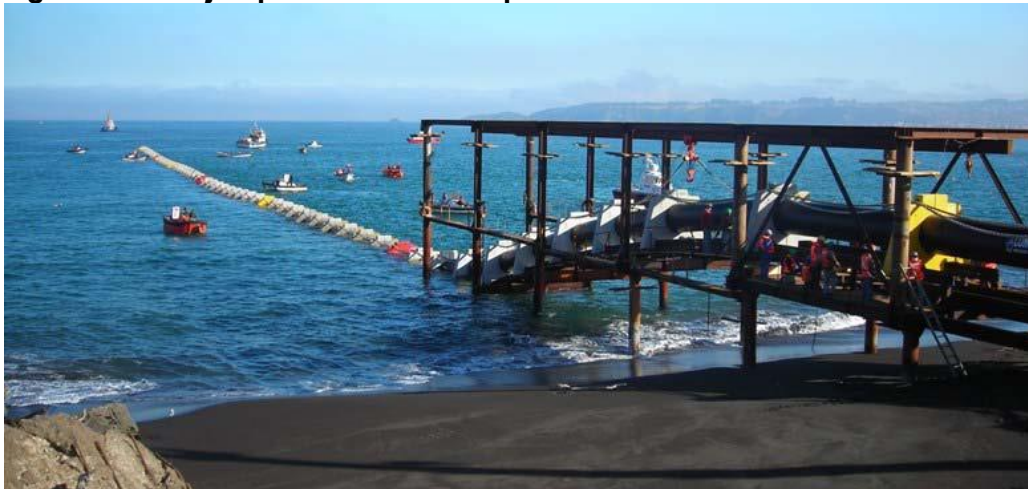
Figura EI-11: Ejemplo de estructura provisoria de lanzamiento de tuberías.
