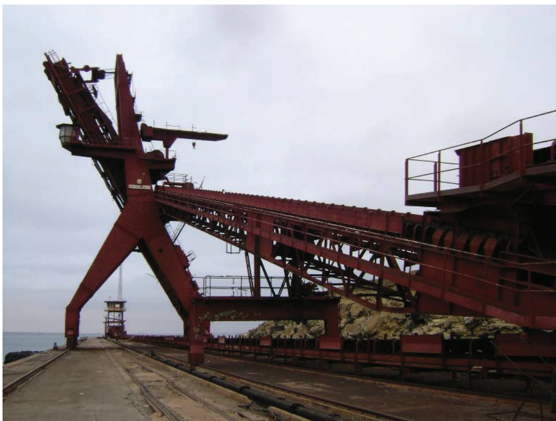
Fotografia 3.7 – Carregador de navios (shiplader) do Porto de Sacomar. O carregador será substituído
