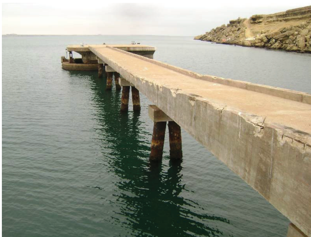
Fotografia 3.10 – Duque de Alba, uma estrutura de apoio à amarração de navios de maior porte, que será alvo de reparações estruturais
