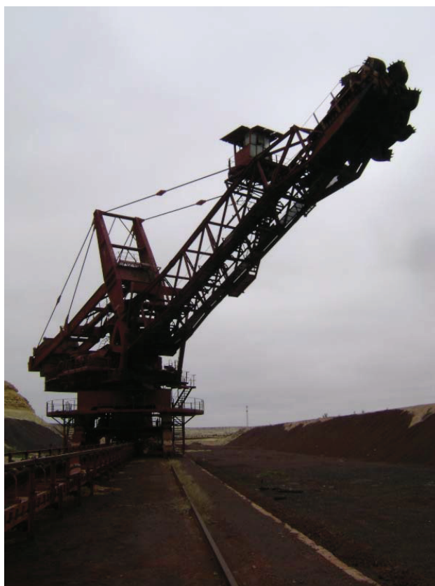
Fotografia 3.5 – Empilhadeira/recuperadora (stacker/reclaimer). As duas empilhadeiras/recuperadoras serão removidas e será instalada uma máquina empilhadeira e uma máquina recuperadora, suficientes para a operação do porto
