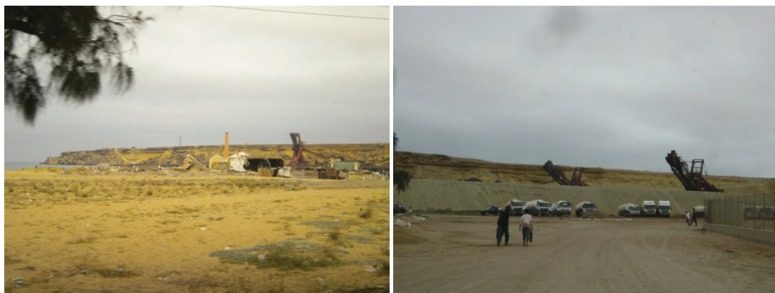
Fotografia 4.23 – Localização exterior do Porto de Sacomar
