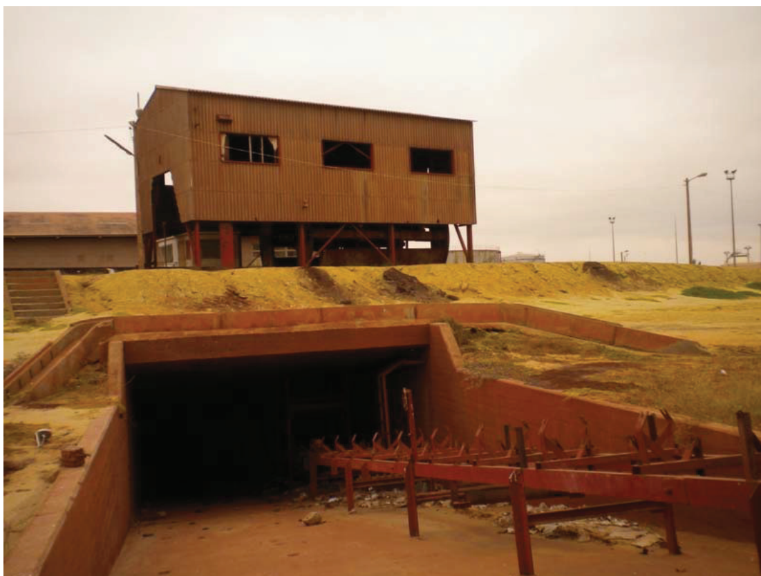
Fotografia 3.3 – Virador de vagões do Porto de Sacomar. Será reparado e reequipado com novos componentes mecânicos
