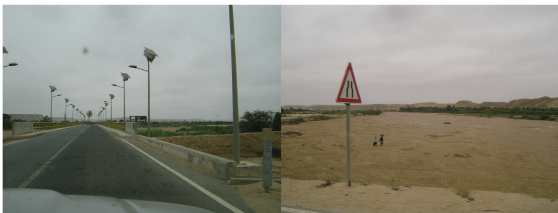
Fotografia 4.6 – Aspectos da Ponte sobre o Rio Giraúl (Leito Seco)
