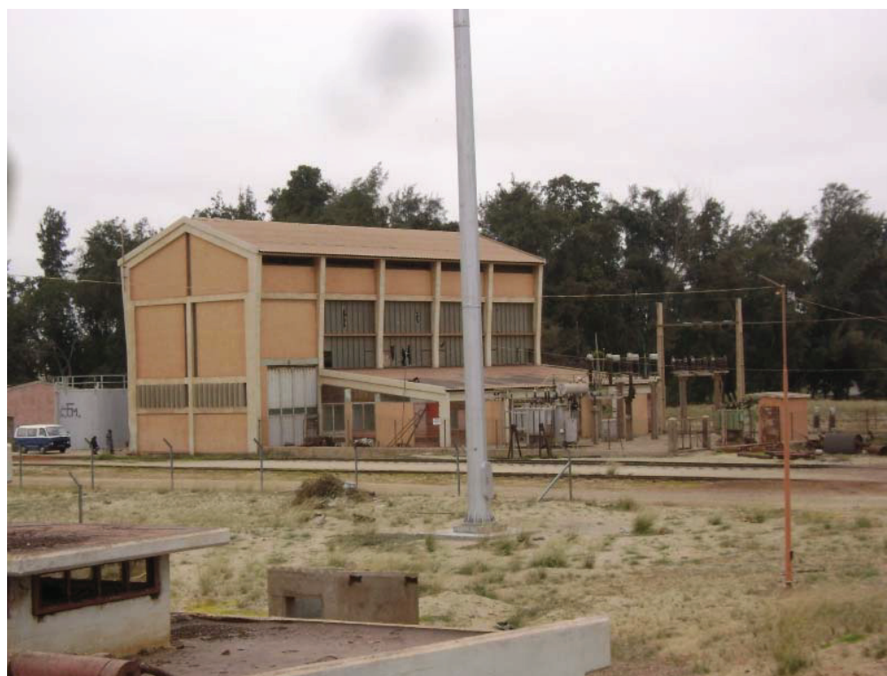
Fotografia 3.2 – Edifício de electricidade, com gerador diesel, que será reabilitado, incluindo a instalação de novos geradores
