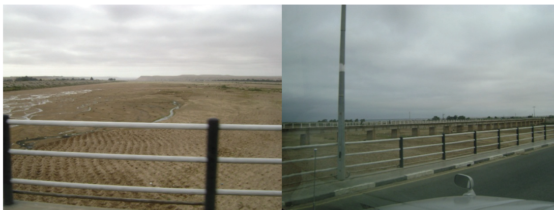
Fotografia 4.7 – Aspectos da Ponte sobre o Rio Bero (Leito Seco)
