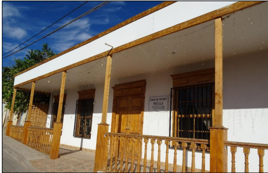
Fuente: MWH (campana de terreno, 2015)
