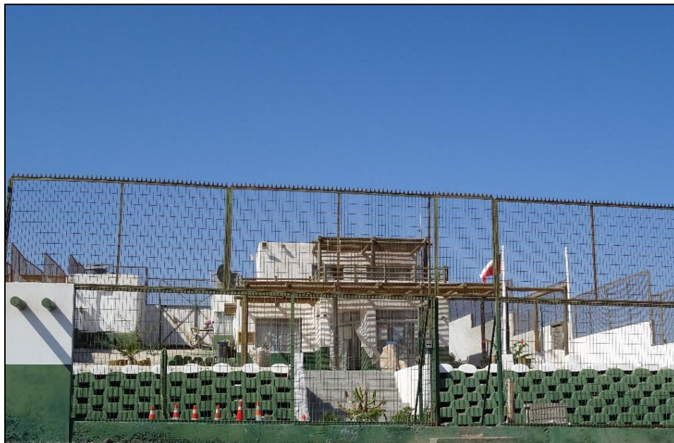
Fuente: MWH (campana de terreno, 2015)
