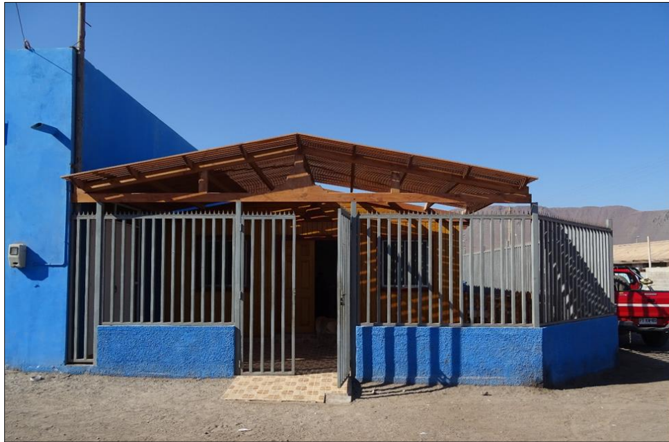
Fotografía 3.12-69. Sede Junta de Vecinos Chanavayita.
