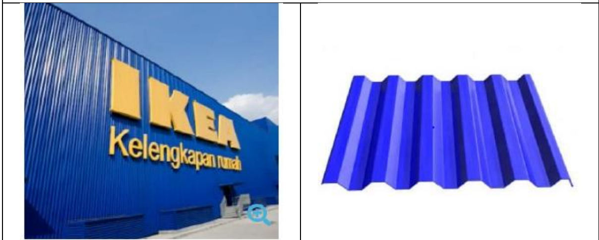
ตัวอย่างกำแพงกันเสียงด้านทิศใต้
