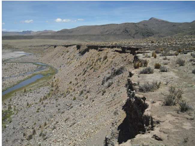
Foto N° 5.4.1-4: Río Hornillos, lecho derecho, erosionado
