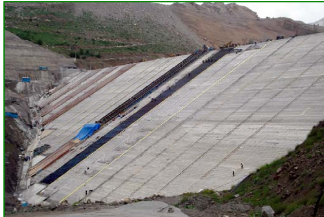
Figura 1-5 Ejecución del plinto y trabajos de la pantalla de concreto apoyada sobre el cuerpo de presa
