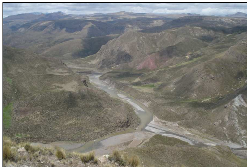
Foto 4.1.2-1: Río Colca. Se observa sobre la derecha la confluencia con el río Chalhuanca, donde descarga el proyectado túnel trasandino Apurímac-Colca.
