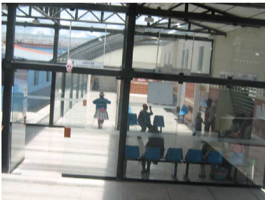
Area destinada a hospitalizacion hospital provincial de Espinar
