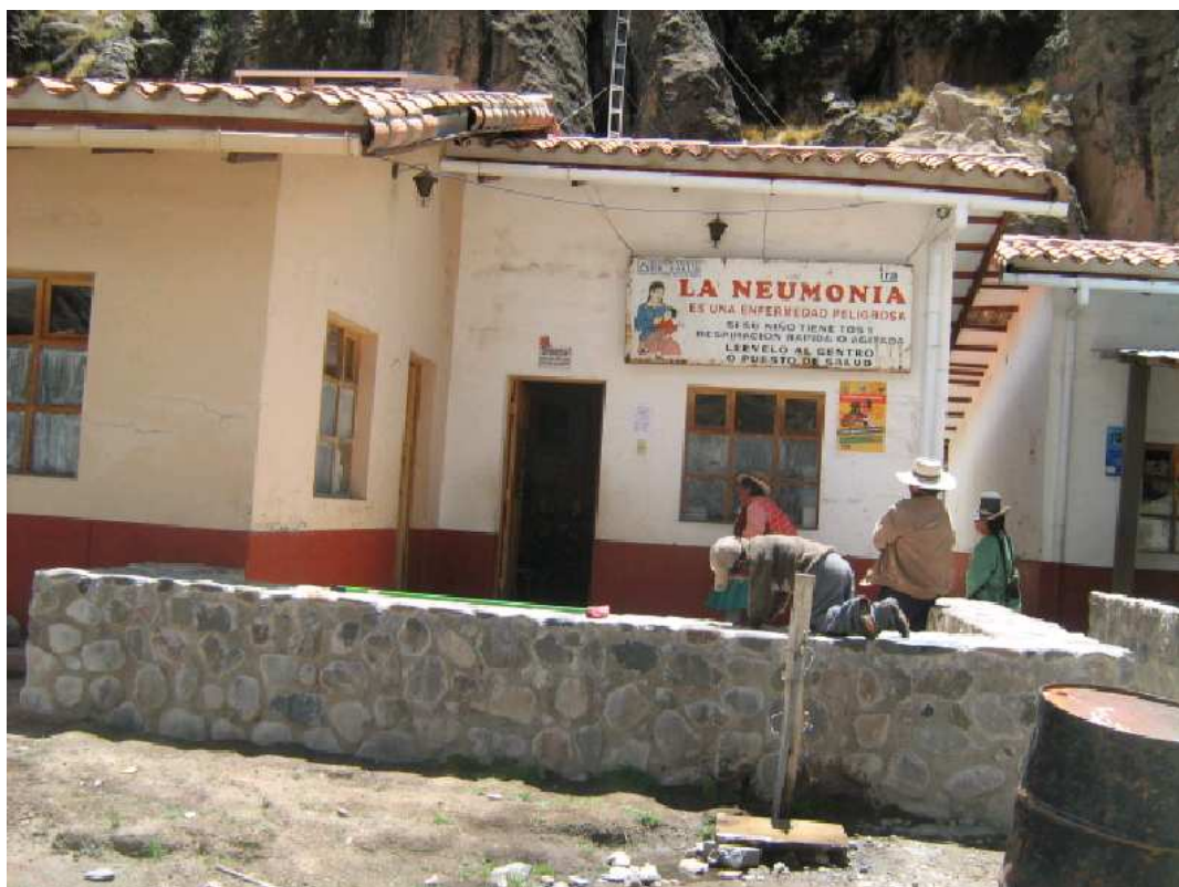
Puesto de salud distrito de Suyckutambo
