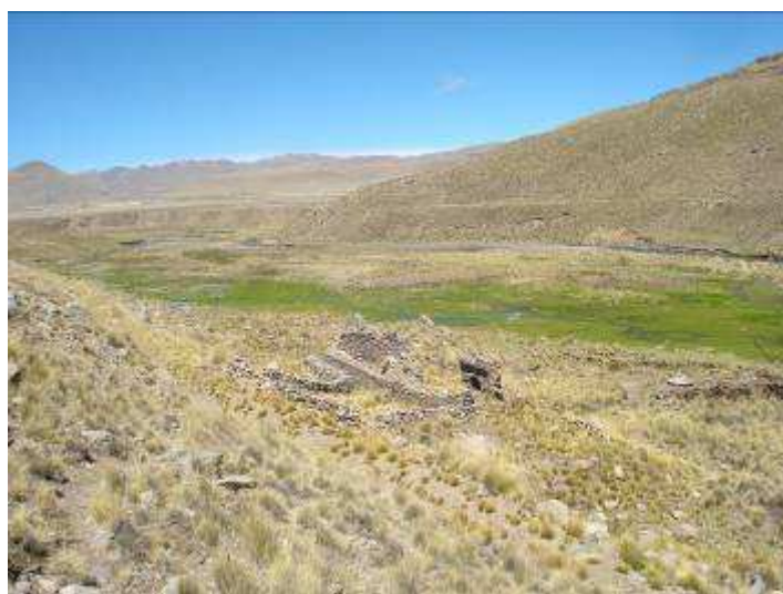
Foto N° 4.5.10-27: Detalle de las estructuras del Molino Colonia cercano a la zona de embalse. Sector Pampa Calera
