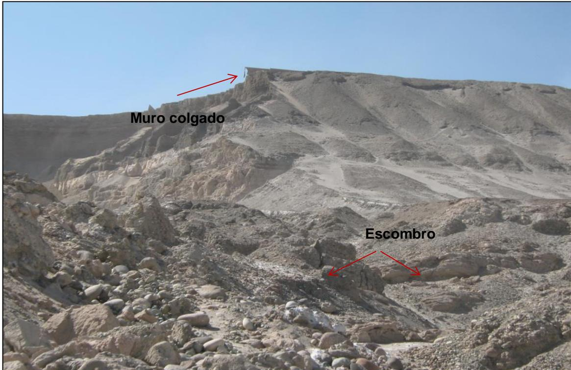
**Foto N° 67.** : Zona del Zarzal próximo a la Planta de la Leche Gloria, véase el muro que ha quedado colgado y el material de escombros desplazado hasta cerca al cauce del río Sigüas.
