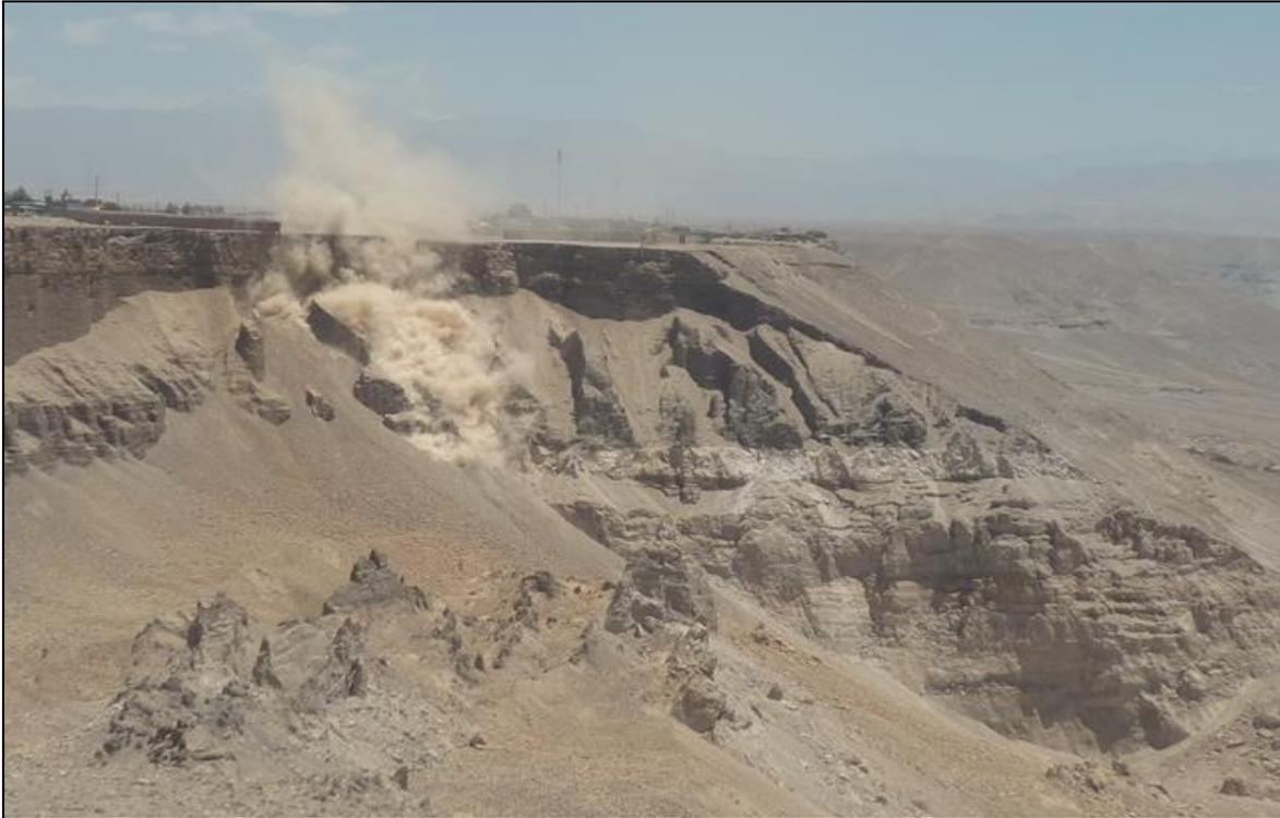
**Foto N° 65.** : Deslizamientos entre El Zarzal y Santa Ana, producto de filtraciones en capas muy permeables que lavan terrenos salitrosos y que desestabilizan los taludes provocando la caída en bloques de grandes dimensiones hacia la cuenca
