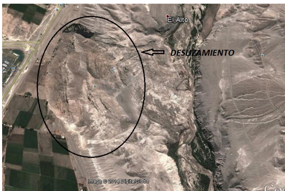
Foto 3.20: Se observa deslizamiento ocurrido en la zona del Zarzal - San Juan de Sigwas
