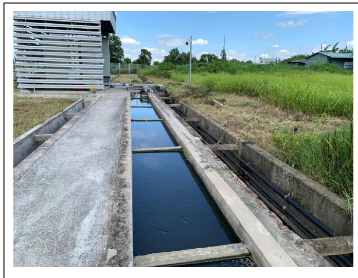
Hình 1.8. Mương dẫn nước sau xử lý ra hồ chứa nước thải sau xử lý
