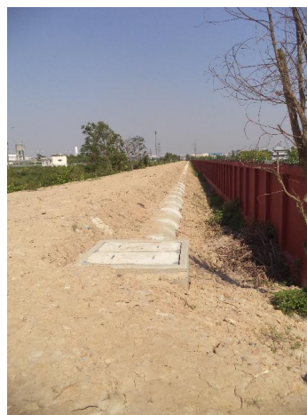
Hình 1.10. Hệ thống thoát nước thải của TLIP II ra kênh Trần Thành Ngọ
