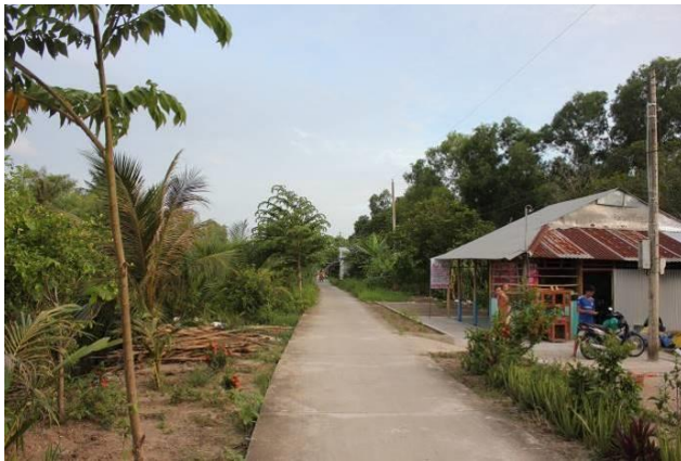
Đường bê tông
