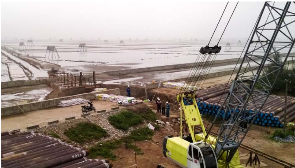
Hình 1.8 Hoạt động lắp đặt đoạn ống gần bờ của một dự án tương tự
