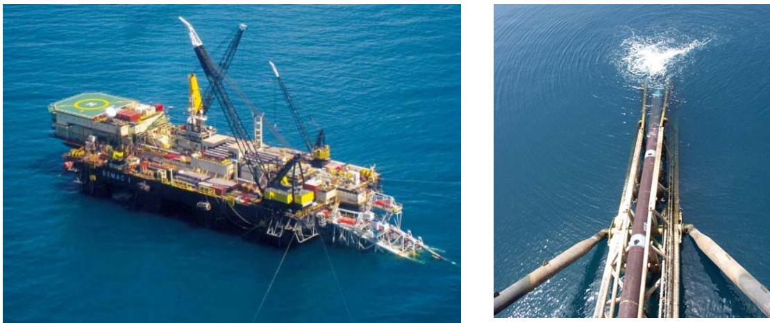
Hình 1.10 Hoạt động lắp đặt tuyến ống ngoài khơi
