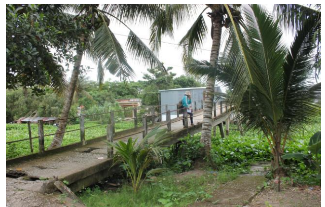
Cầu bê tông vào khu dân cư
