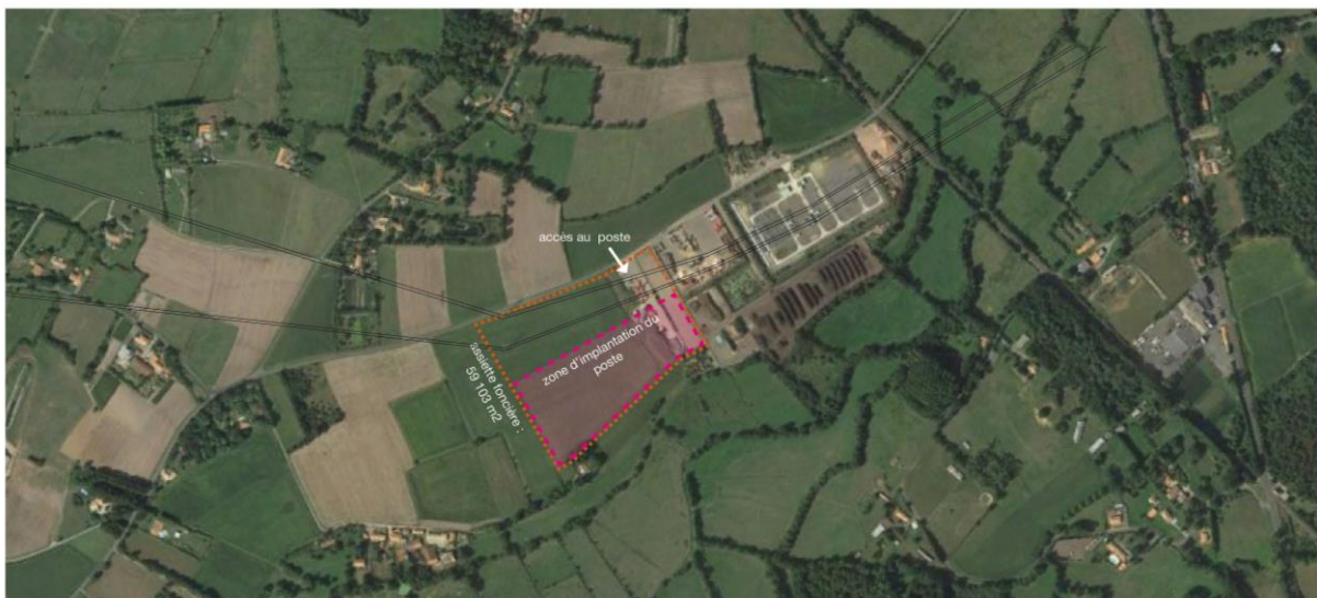
Figure 22 : Vue aérienne de l'emprise du poste
