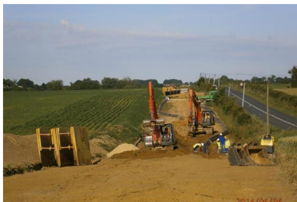
Exemple de pose
