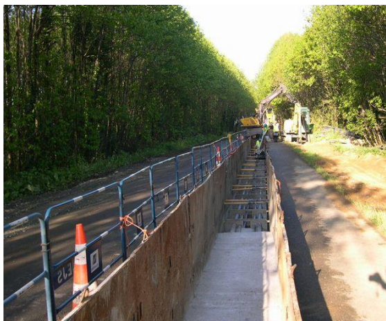
Pose en demi-chaussée
