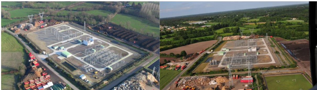
Photographie 7 : Poste de raccordement de Soullans
